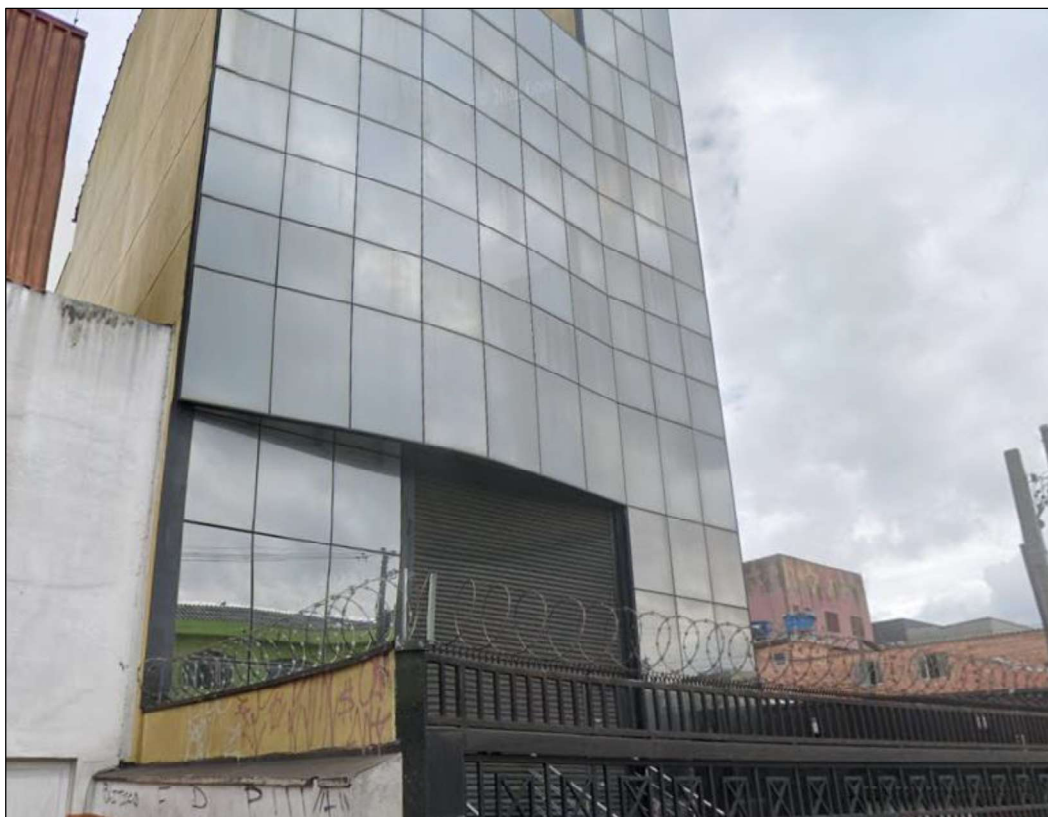
Figura 11: Fachada do imóvel referencial 6.
