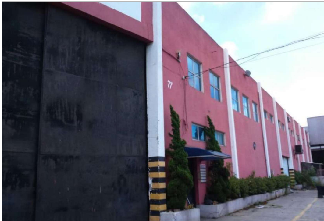
Figura 9: Fachada do imóvel referencial 4.
