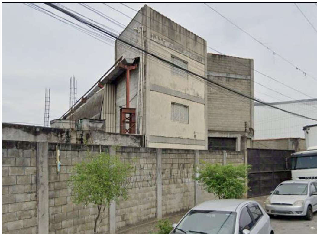
Figura 6: Fachada do imóvel referencial 1.
