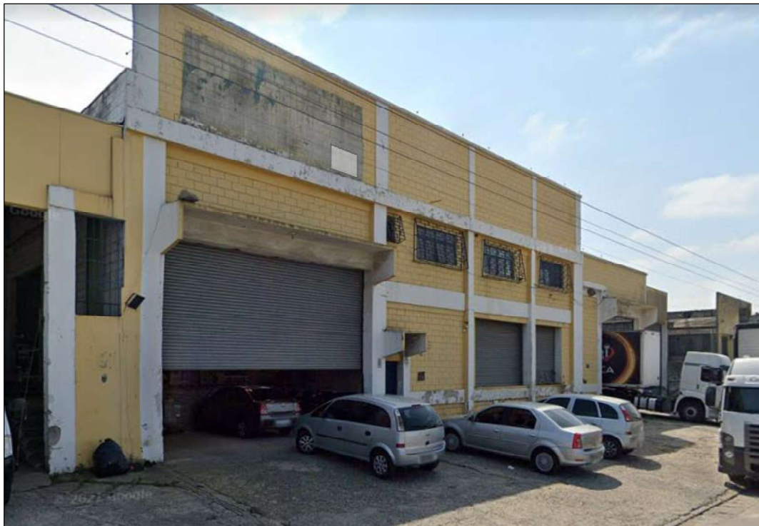
Figura 10: Fachada do imóvel referencial 5.
