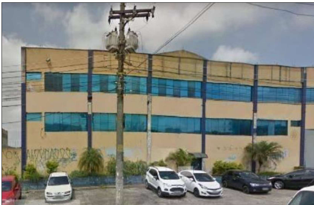
Figura 8: Fachada do imóvel referencial 3.
