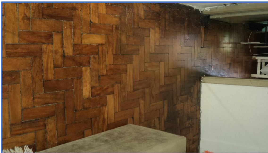
Foto: piso de tacos de madeira.
