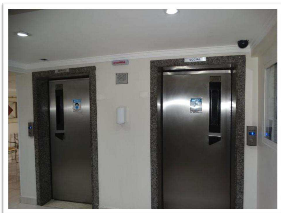
Foto nº 8 - Vista do hall de elevadores no pavimento térreo do bloco 17.
