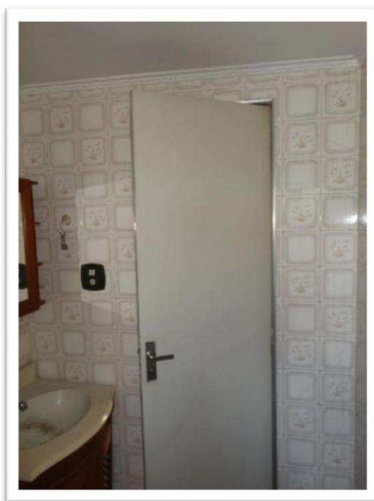
Foto nº 31 - Vista parcial interna do apartamento nº 44 – Banheiro.
