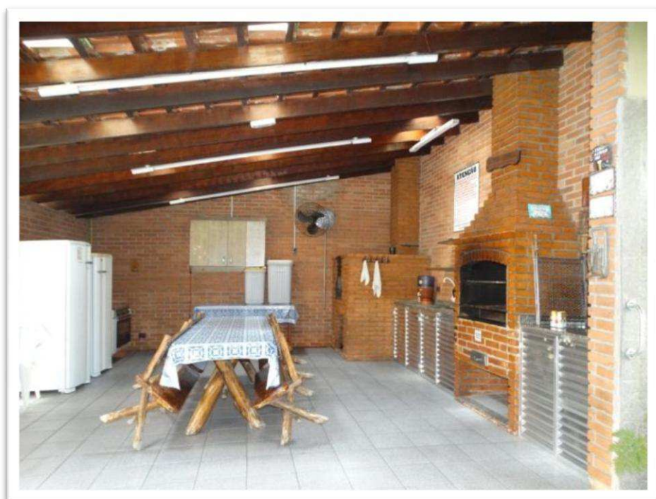
Foto nº 37 - Vista parcial da área de lazer no pavimento térreo do bloco 17 – Churrasqueira.
