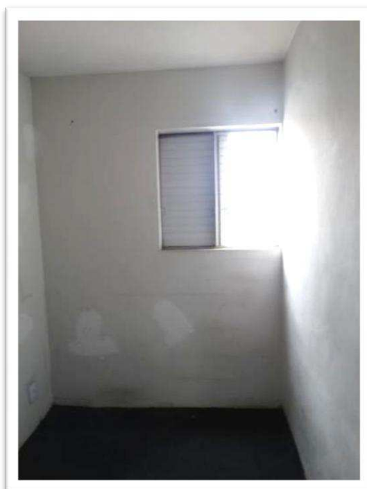
Foto nº 22 - Vista parcial interna do apartamento nº 44 – Dormitório 1.
