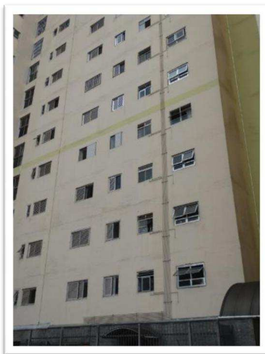
Foto nº 5 - Vista parcial da fachada externa do Bloco 17, onde se localiza o apartamento nº 44, objeto da presente vistoria.
