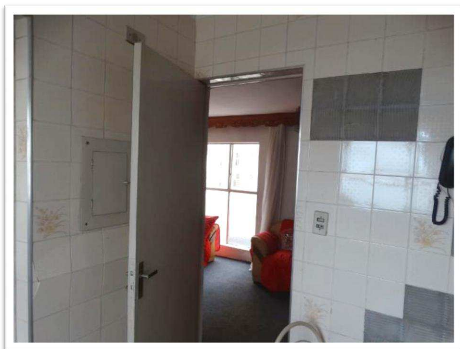
Foto nº 14 - Vista parcial interna do apartamento nº 44 – Cozinha.
