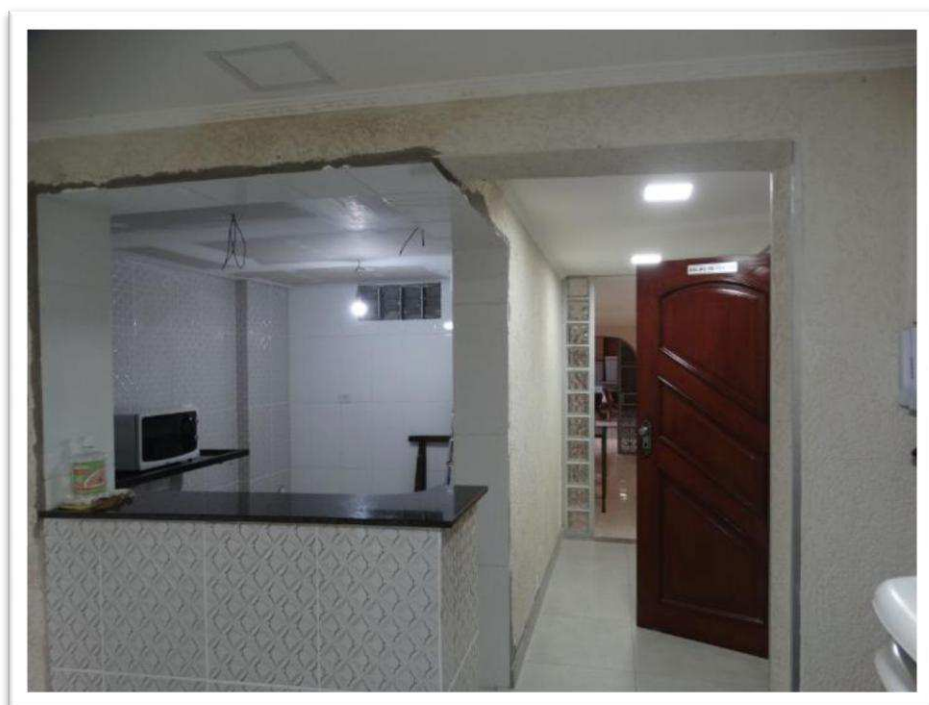
Foto nº 40 - Outra vista parcial do salão de festas no pavimento térreo do bloco 17.
