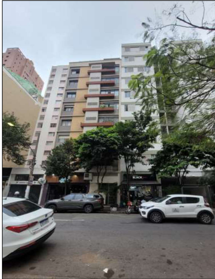
VISTA DA FACHADA DO EDIFÍCIO SÃO SEBASTIÃO.
