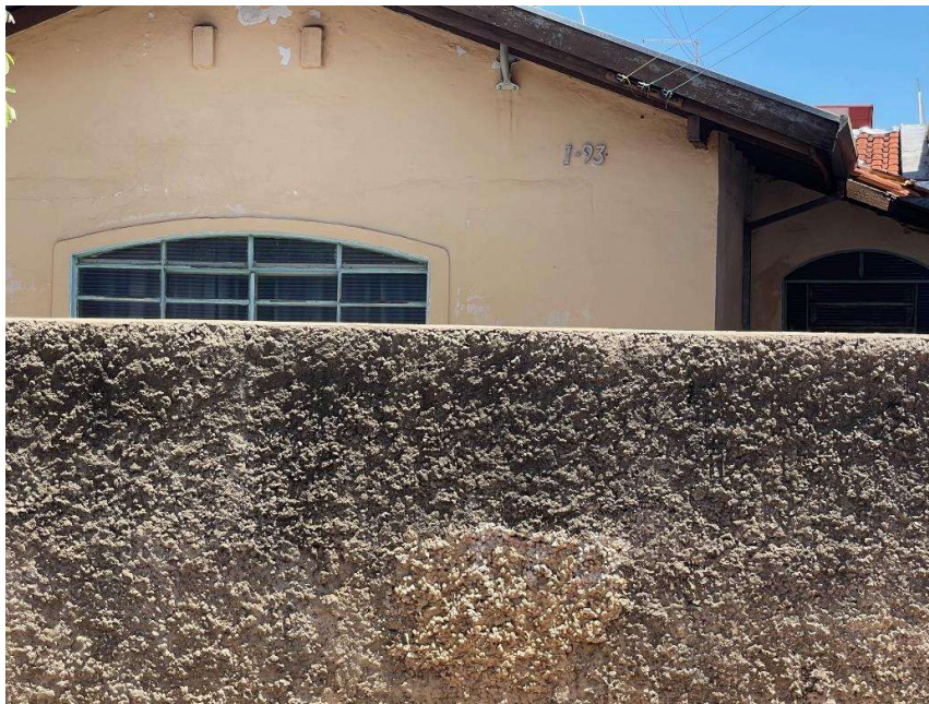
Foto 01. Elevação principal do imóvel. Rua São João, 1-93
