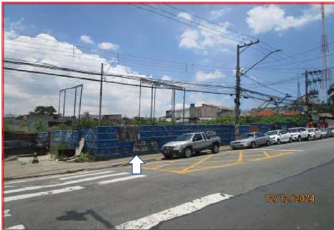
Foto nº 02: Vista da fachada do imóvel voltada para a Avenida General Pedro Pinho.
