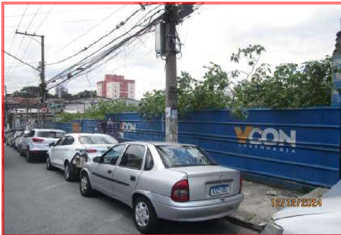
Foto nº 04: Vista da fachada do imóvel voltada para a Avenida General Pedro Pinho, tomada no sentido oposto.
