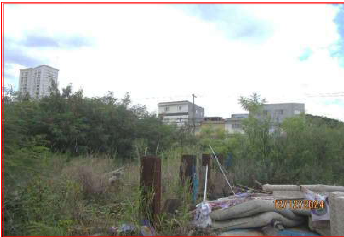
Foto nº 09: Vista do interior da área, onde se observa estado de abandono.
