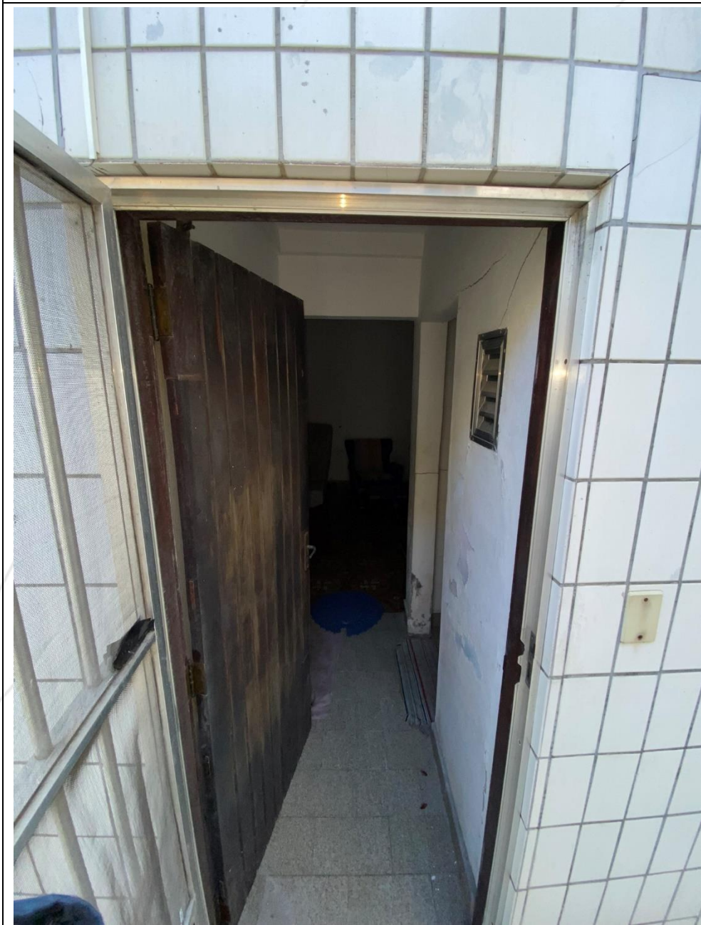
FOTOGRAFIA 06 – VISTA GERAL DA ENTRADA DO IMÓVEL DESTE PRESENTE TRABALHO.
