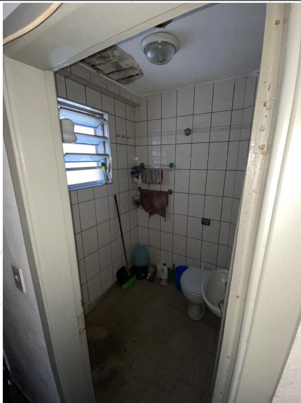
FOTOGRAFIA 18 – VISTA GERAL DO BANHEIRO SOCIAL DO IMÓVEL DESTA PRESENTE TRABALHO.
