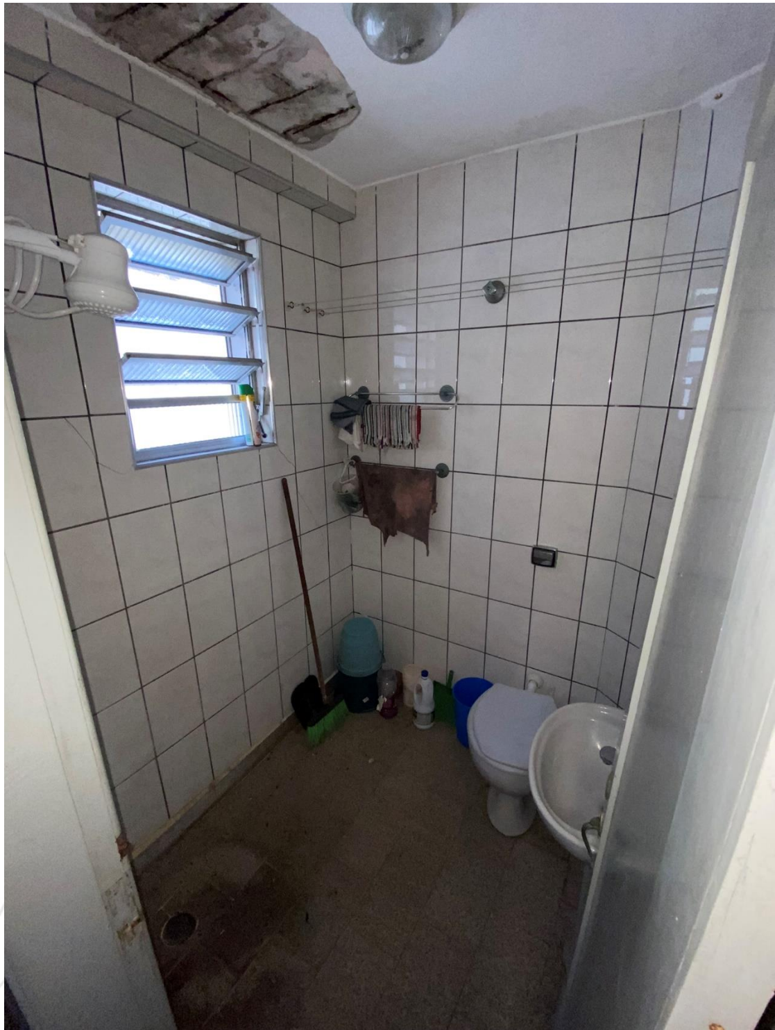
FOTOGRAFIA 19 – VISTA GERAL DO BANHEIRO SOCIAL DO IMÓVEL DESTA PRESENTE TRABALHO.
