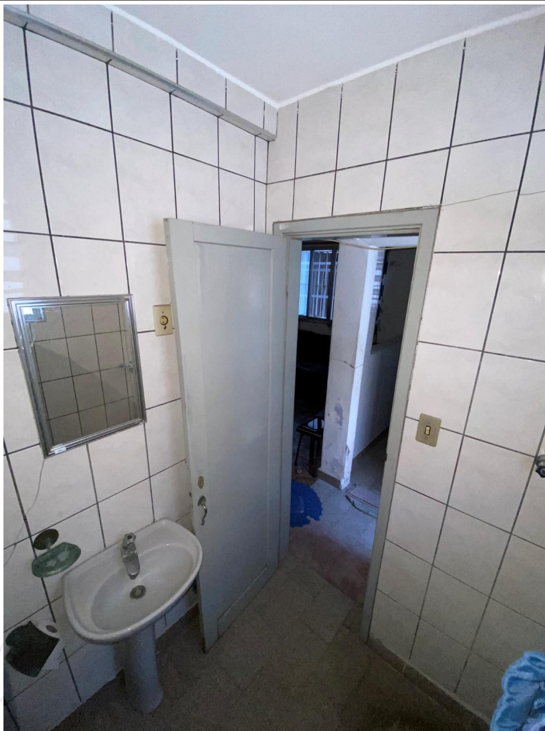
FOTOGRAFIA 20 – VISTA GERAL DO BANHEIRO SOCIAL DO IMÓVEL DESTA PRESENTE TRABALHO.
