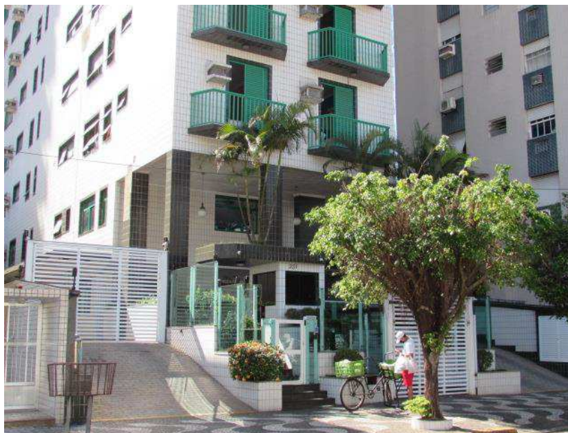
Foto 02 – Vista do acesso para o interior do Condomínio.
