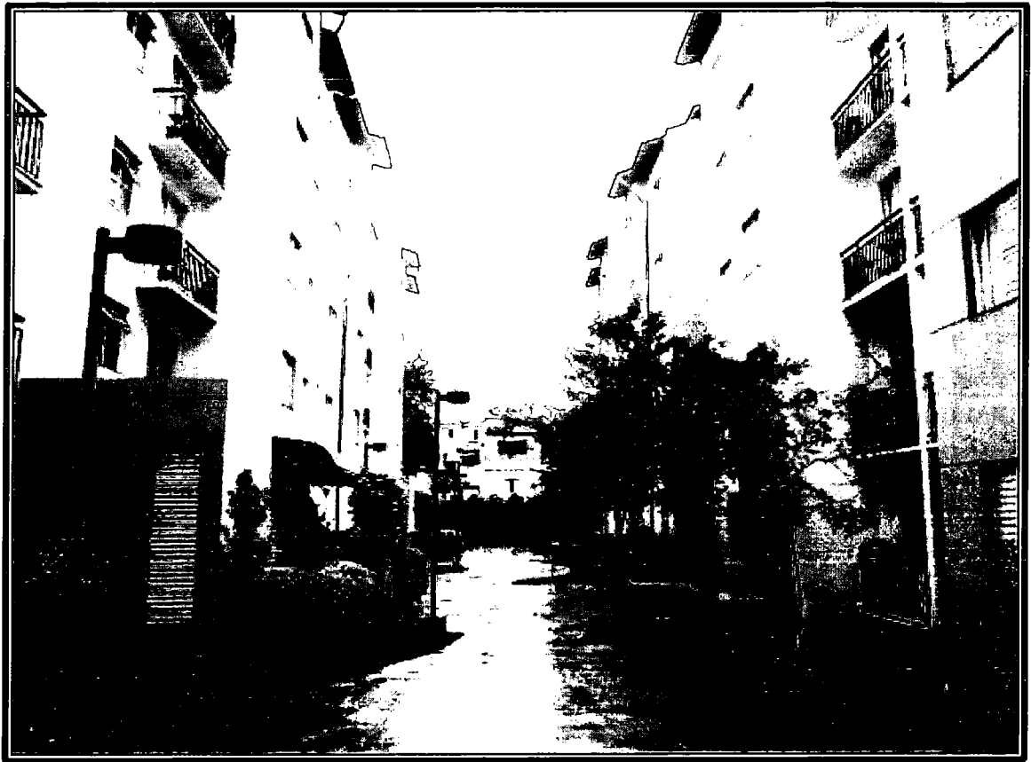
Foto destacando o acesso ao Edifício Bloco 3, do Conjunto Residencial SAN MARINO II.
