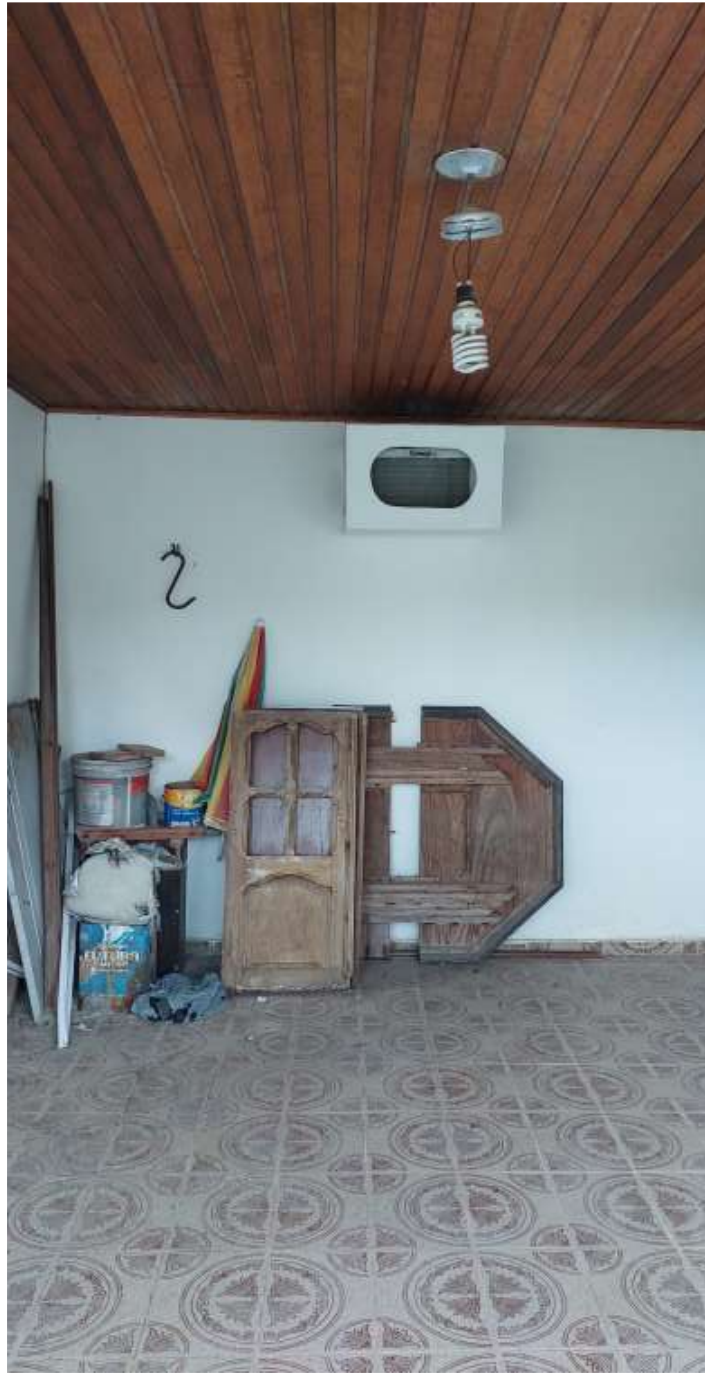
Detalhe da garagem
