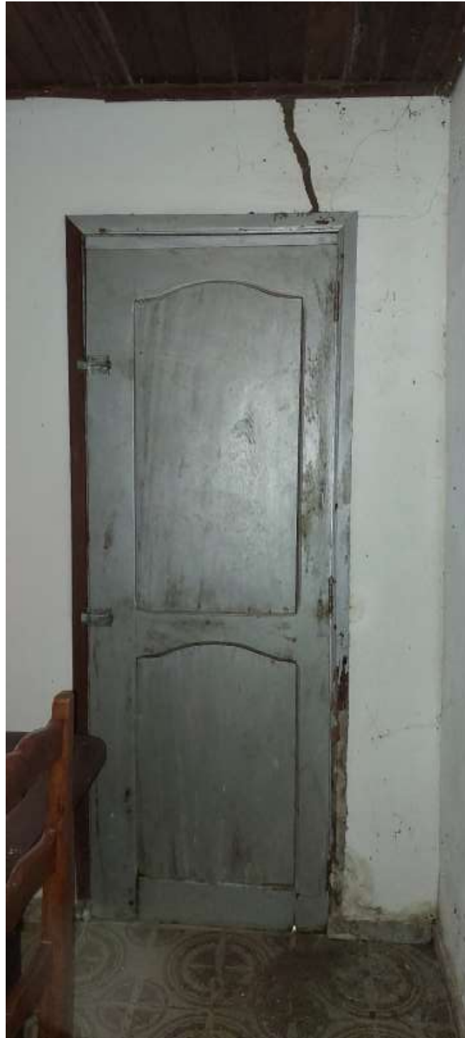
Detalhe da porta da cozinha
