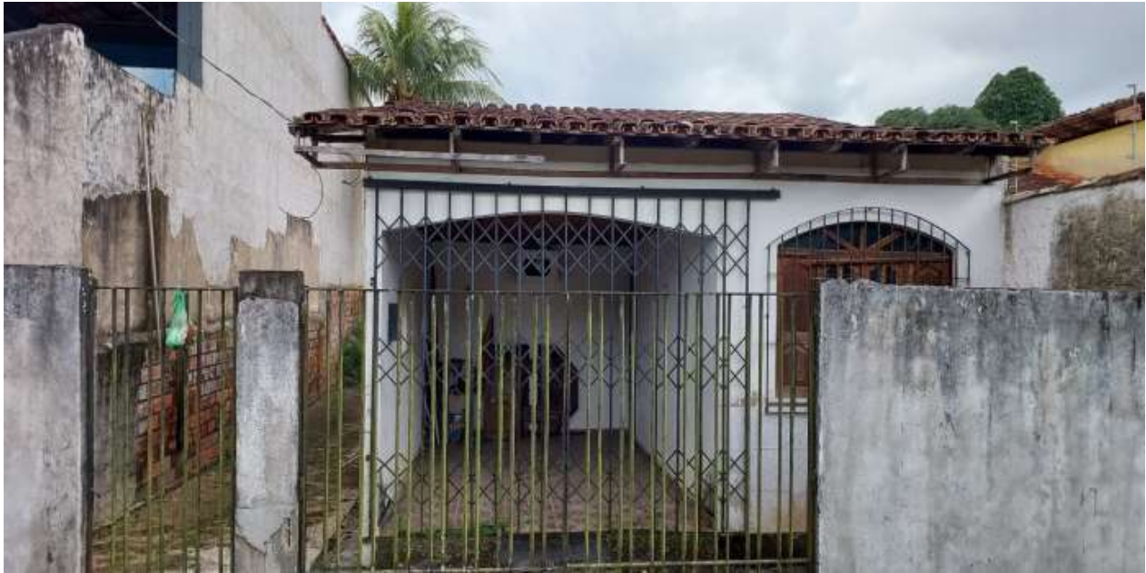
Vista frontal da casa, fora do terreno
