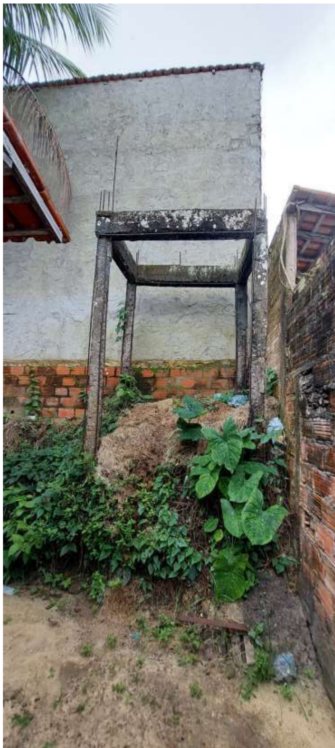
Estrutura de apoio da caixa d'água
