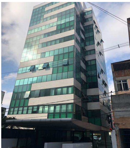
Vista da fachada frontal
