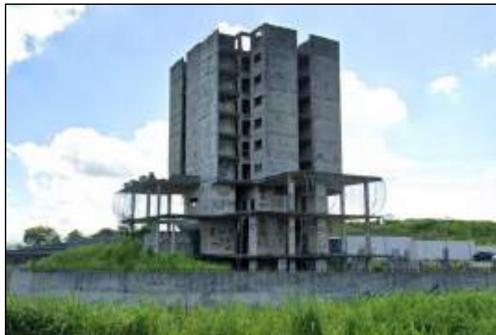
Vista parcial frontal do imóvel avaliando.
