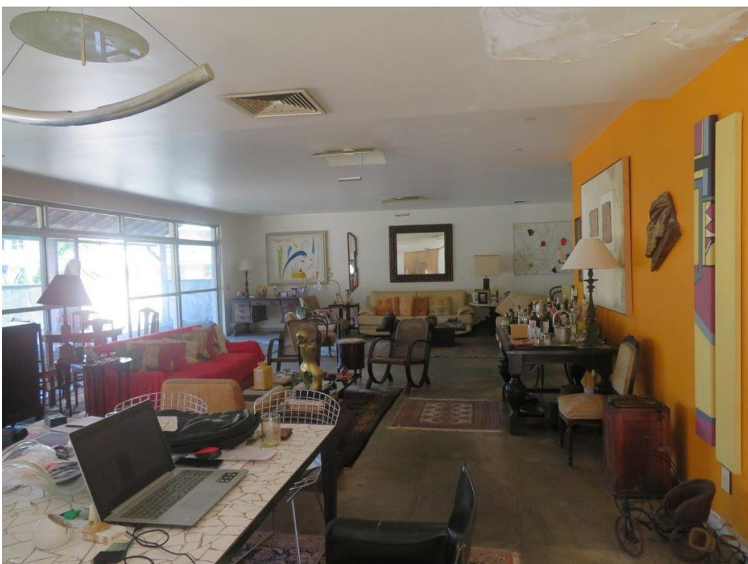
Foto 5-C – Local com reparo de vazamento executado e em discussão entre as partes. A abertura no teto de gesso para visita e reparo permaneceu.
