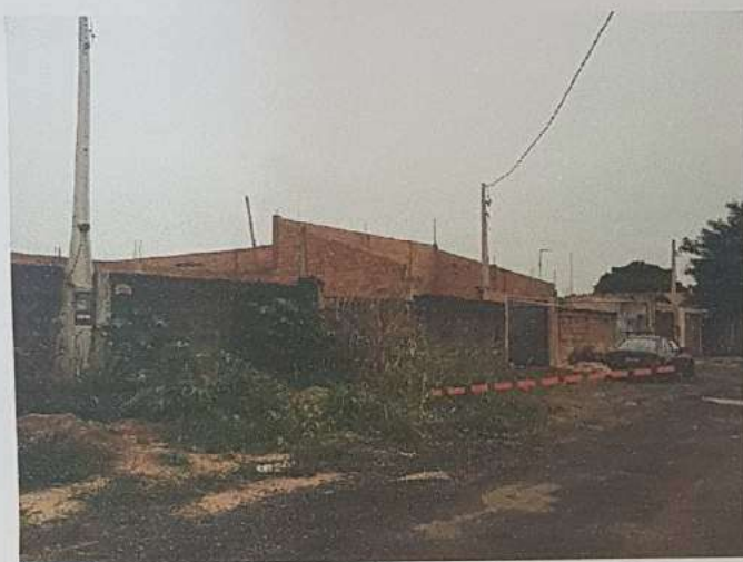
Foto 5 – Imagens dos imóveis – Rua João Pavanati Em construção – Lado oposto aos Imóveis 15 e 15B da Rua “1”.
