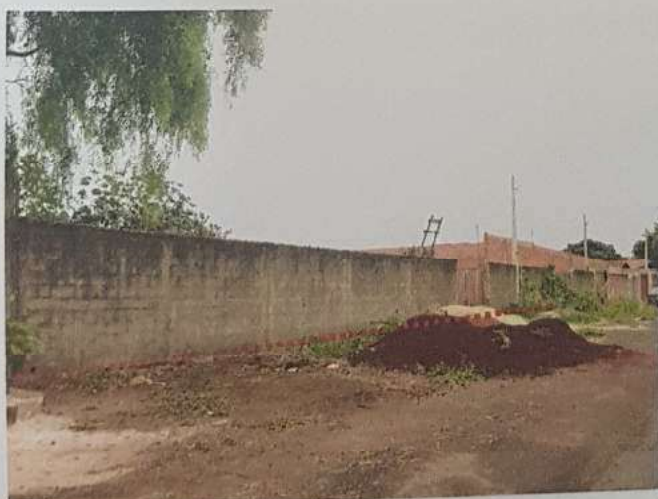
Foto 4 – Vista do Imóvel maior – Rua João Pavanati – oposta a Rua “1”.
