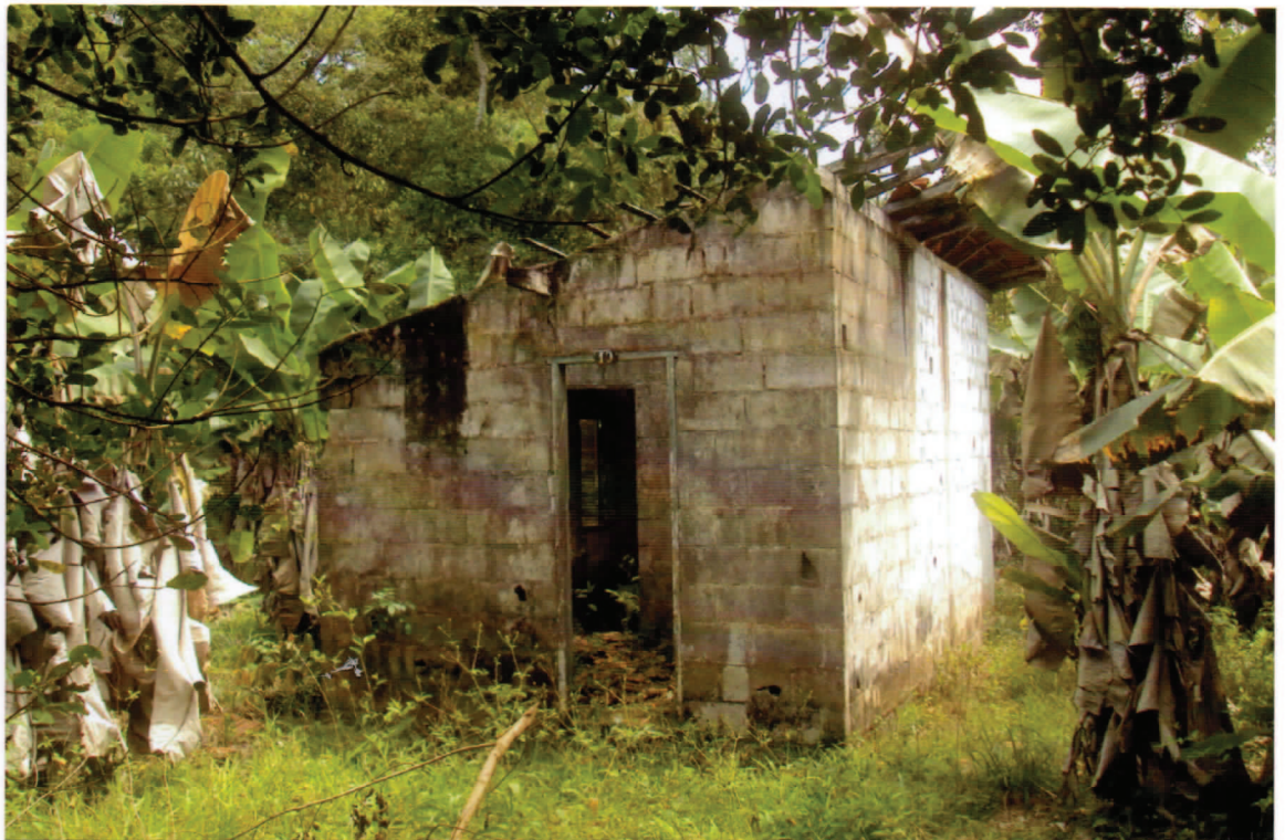
Foto nº 9 – Outra vista do interior do Sítio São Nicolau, observando-se uma das casas existentes, em alvenaria de bloco aparente e em estado precário, necessitando de ampla reforma. Não há rede de energia elétrica.
