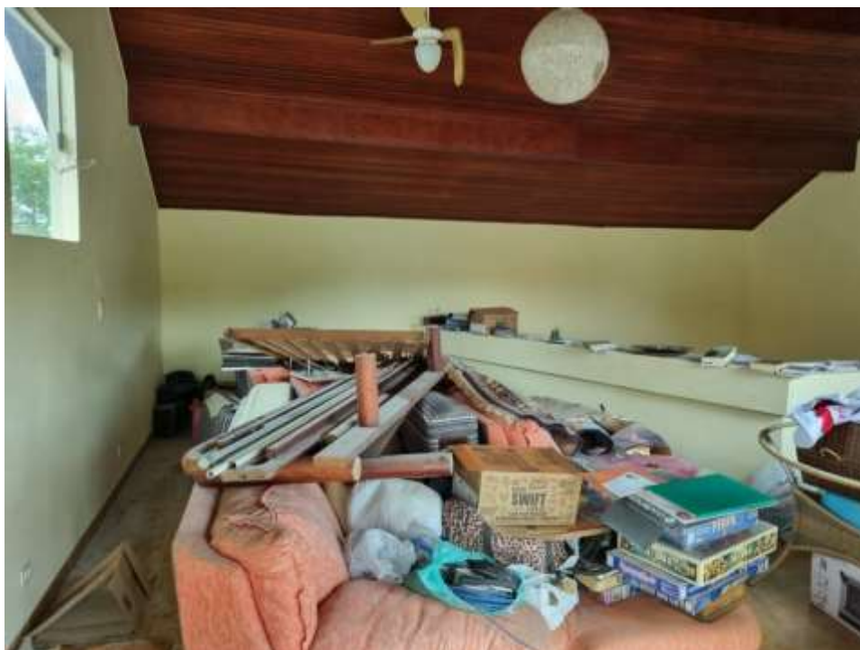
Foto 27 – Vista geral do mezanino, outro ângulo.
