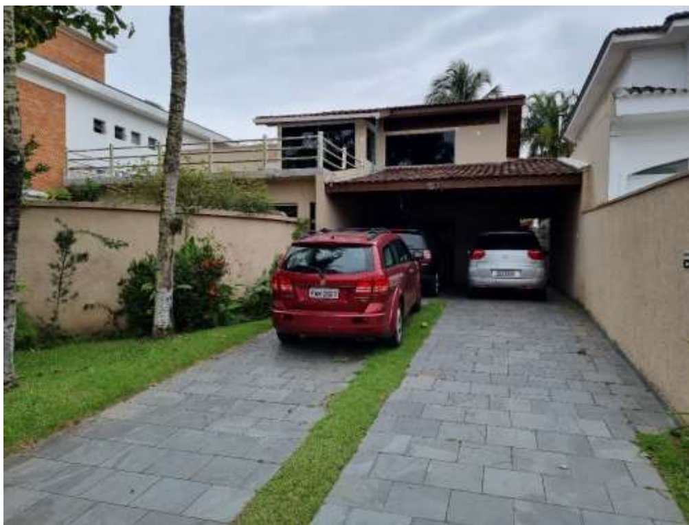
Foto 3 – Vista geral da garagem coberta para 02 (dois) carros.
