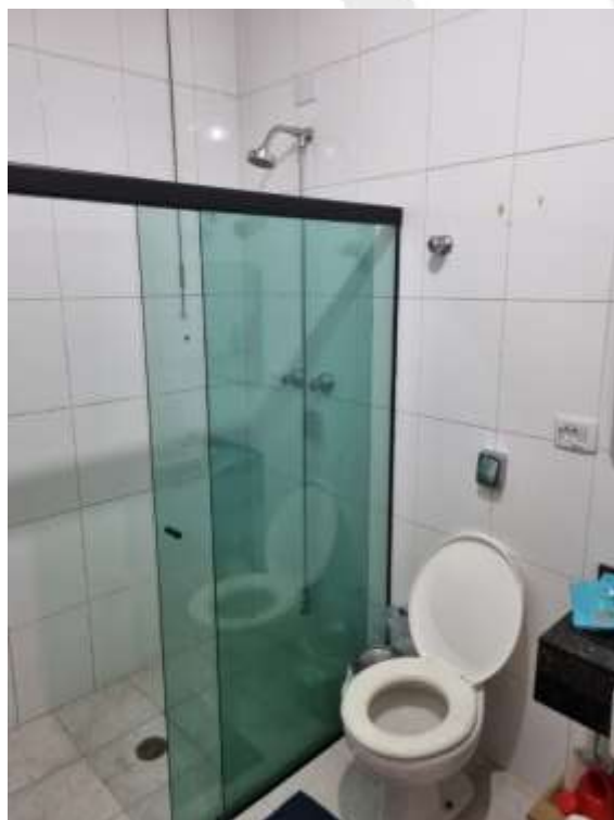
Foto 22 – Vista geral do banheiro social.
