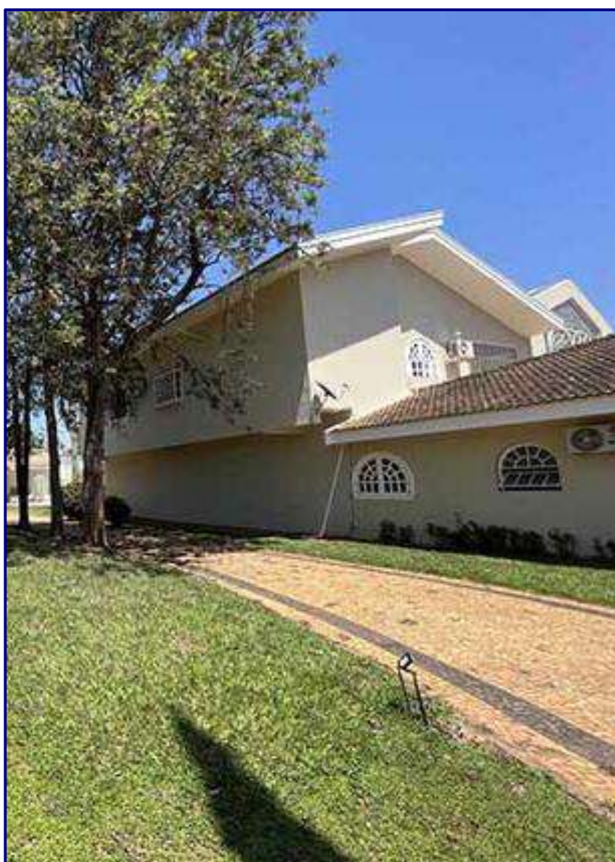
Fachada lateral esquerda
