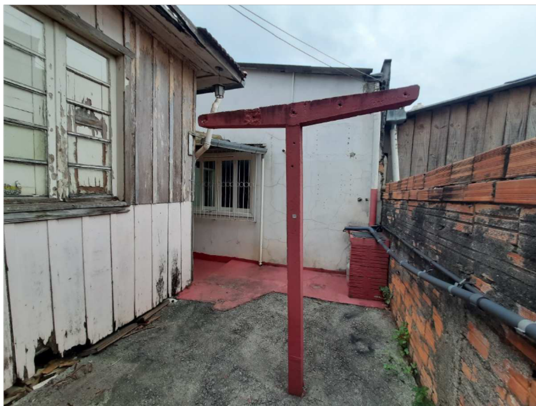
Fotografia 05 – Aspecto externo da construção existente.
