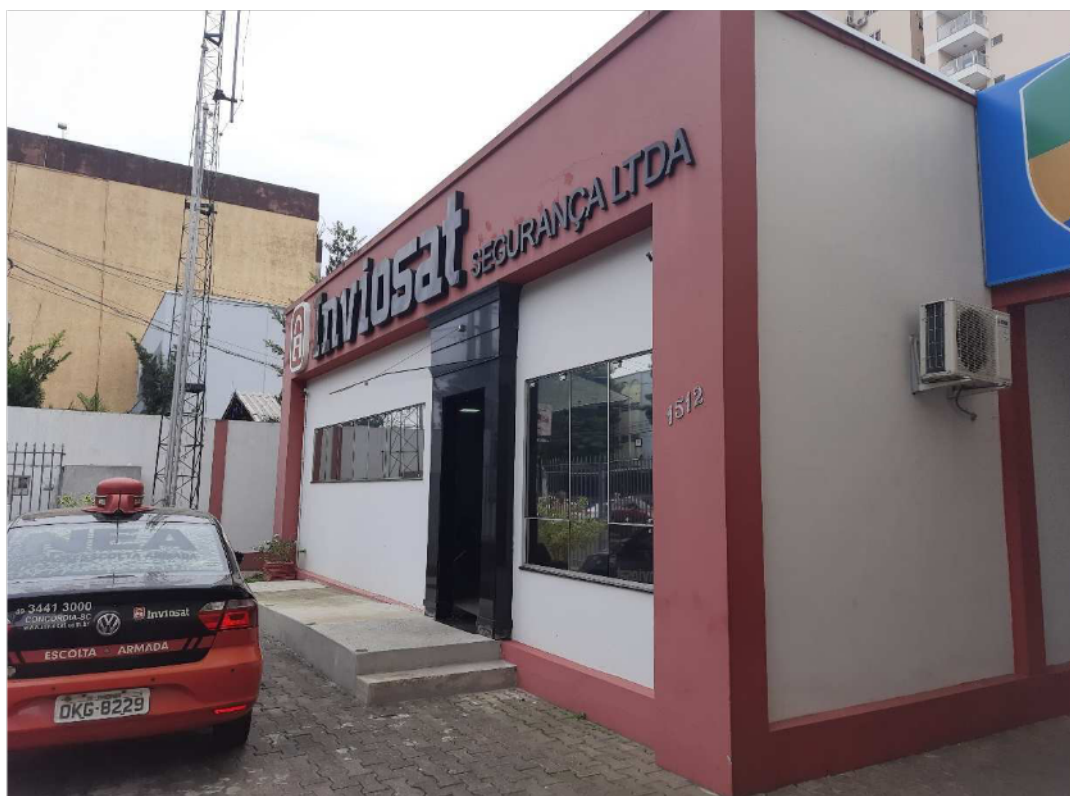
Fotografia 04 – Aspecto da fachada frontal do imóvel avaliado.
