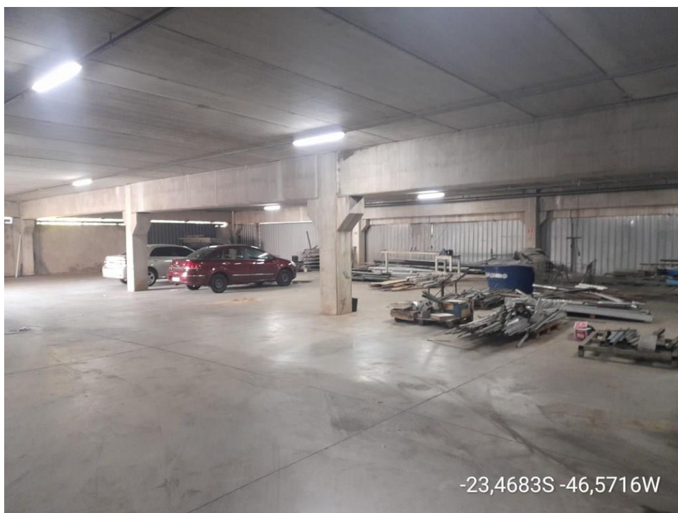
VISTA GARAGEM SUBSOLO
