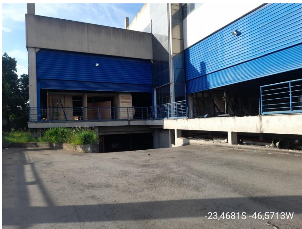
ACESSO A GARAGEM SUBSOLO
