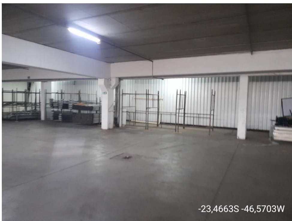
VISTA GARAGEM SUBSOLO
