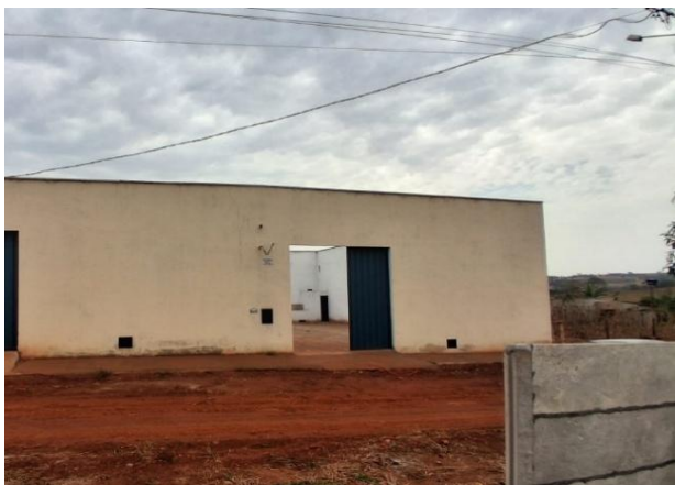
Fachada do avaliando
