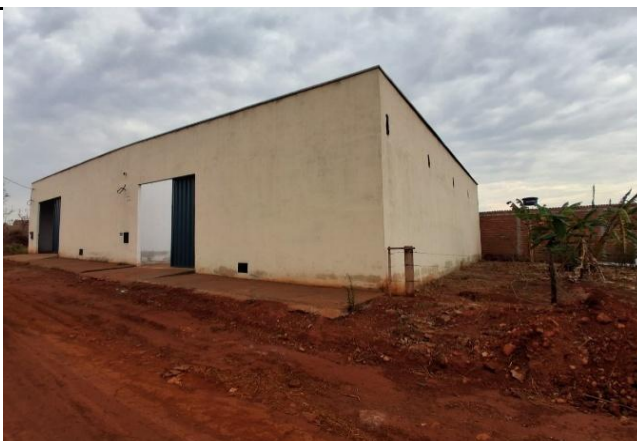
Fachada do avaliando
