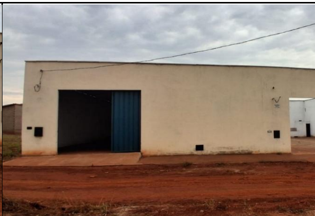
Fachada do avaliando
