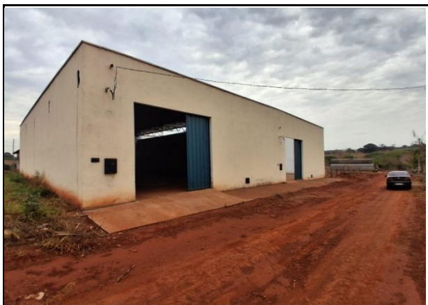
Fachada do avaliando
