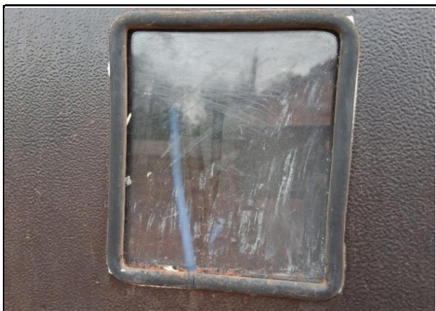
Medidor de energia
