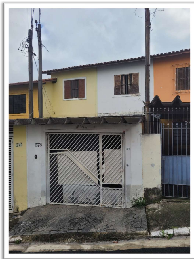
FOTO 02 – VISTA FACHADA FRONTAL IMÓVEL
