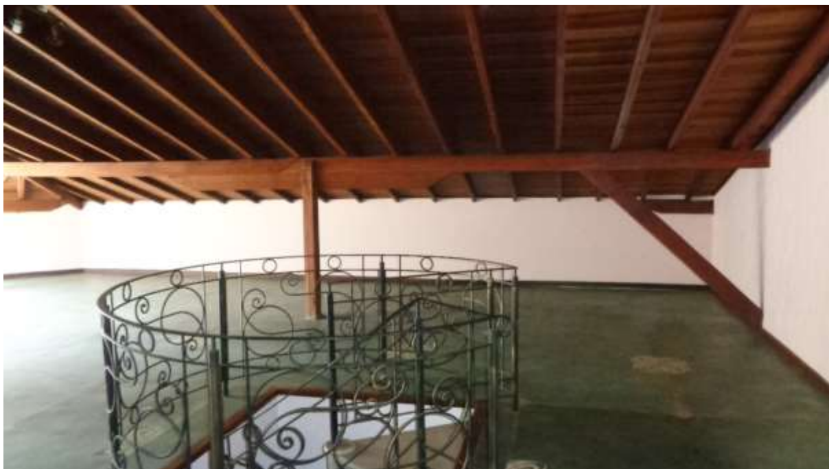
FOTO N.º 47- Tomada da escada de acesso do mezanino ao pavimento superior.
