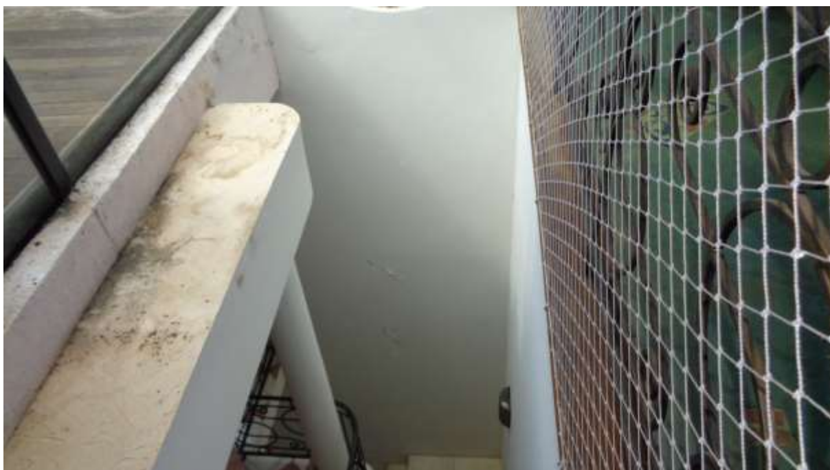
FOTO N.º 46- Detalhe da escada de acesso do mezanino ao pavimento superior.
