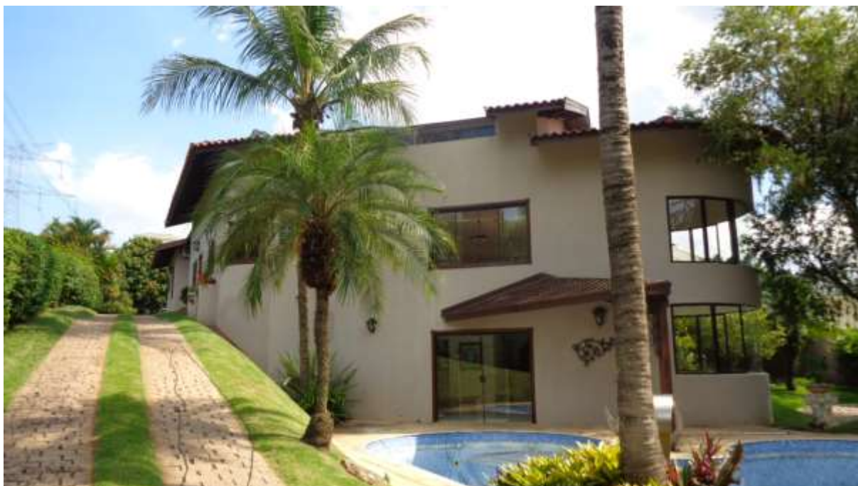
FOTO N.º 01- Aspecto da rampa de acesso a garagem do imóvel.
