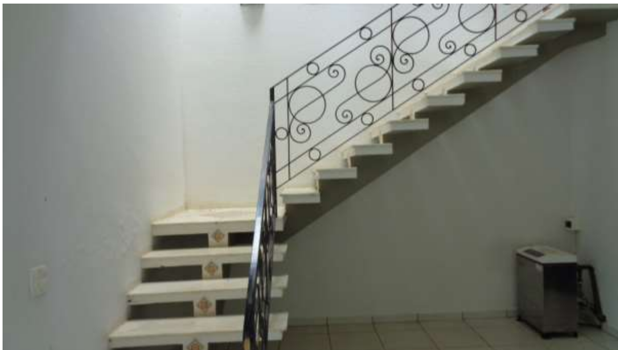
FOTO N.º 27- Detalhe da escada de acesso do pavimento térreo ao pavimento superior.
