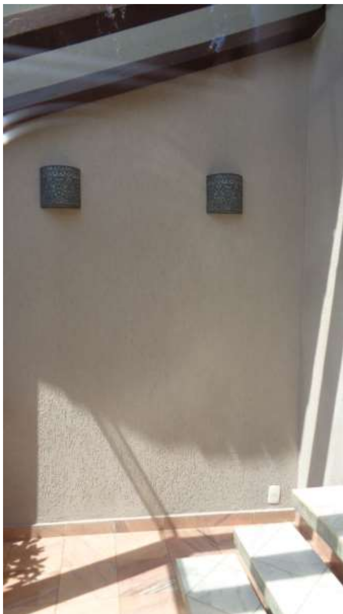
FOTO N.º 14- Vista do acesso secundário ao imóvel.
