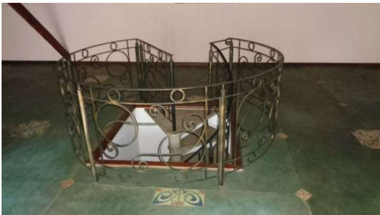
FOTO N.º 48- Detalhe da escada de acesso do mezanino ao pavimento superior.
