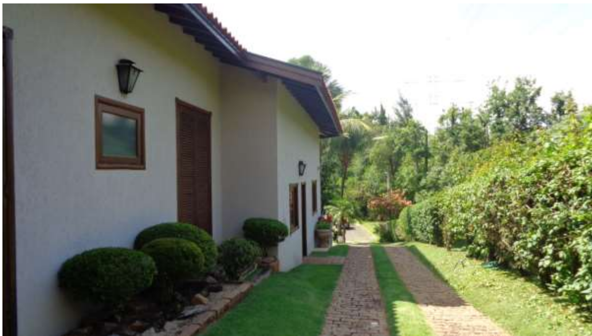
FOTO N.º 19- Vista da lateral esquerda do imóvel no sentido dos fundos para a frente.
