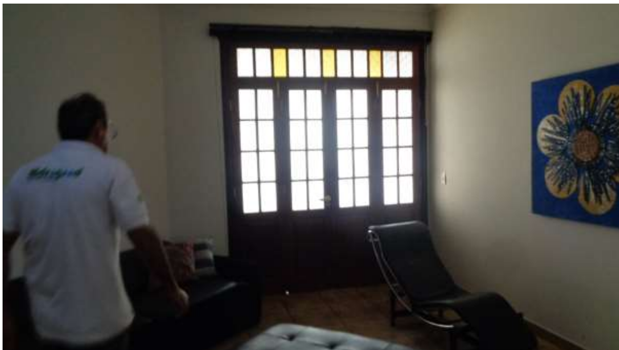
FOTO N.º 31- Aspecto da porta de acesso a varanda.
