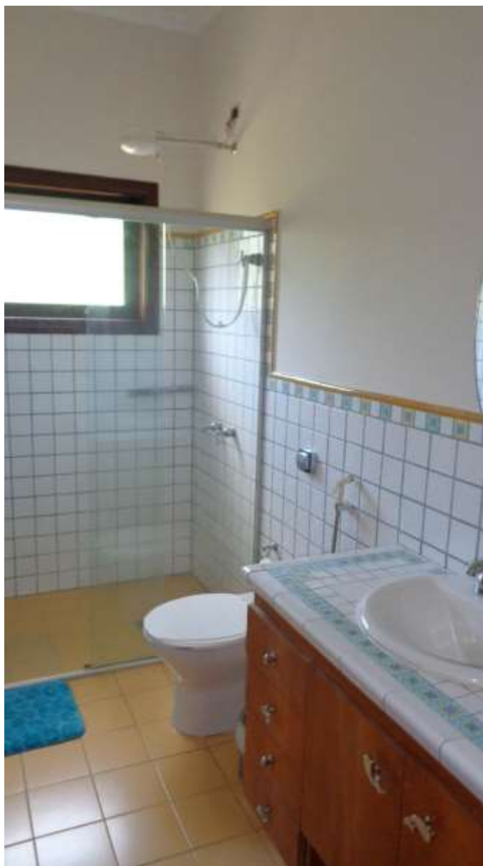
FOTO N.º 35- Detalhe interno do banheiro da suíte de n.º 01.
