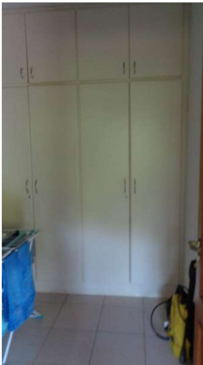
FOTO N.º 20- Detalhe interno da lavanderia.
