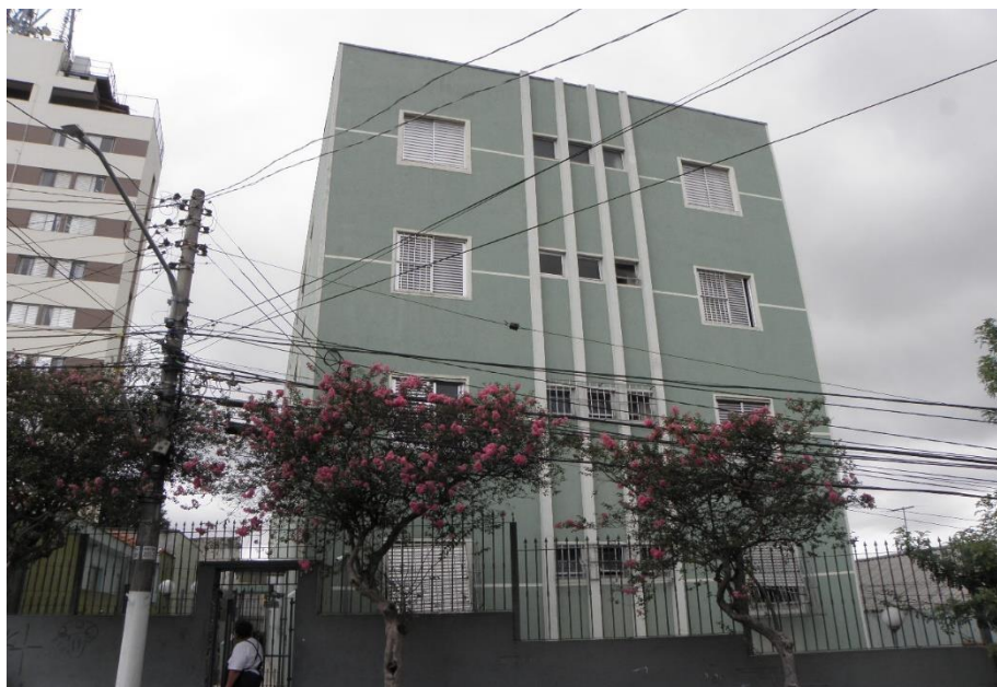
Foto: Fachada do prédio.
