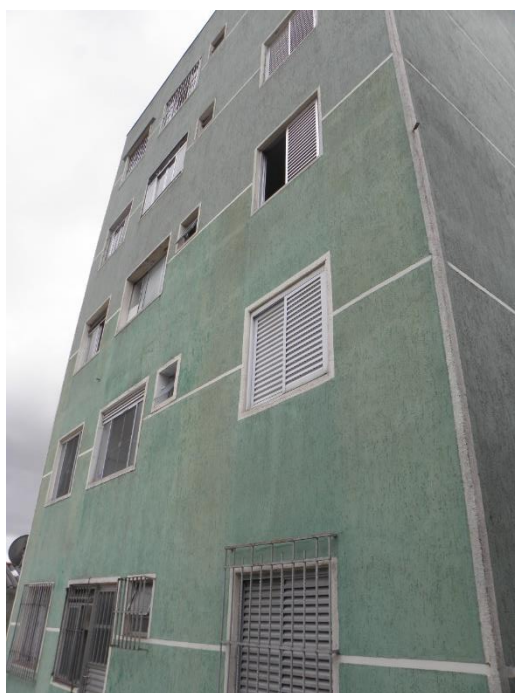
Foto: Fachada dos fundos.
