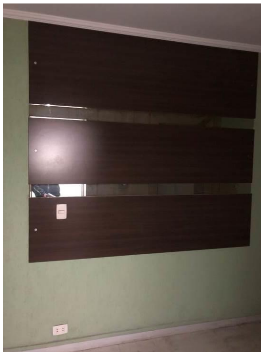
Foto nº 10: Vista do hall no 6º andar.
