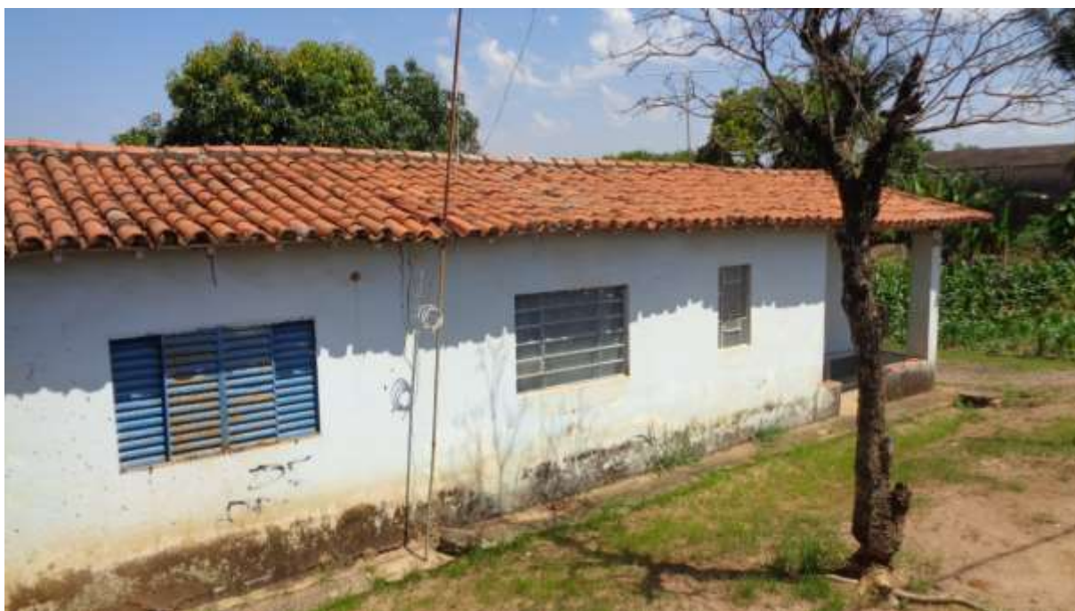
FOTO N.º 10- Tomada da construção do imóvel avaliando.
