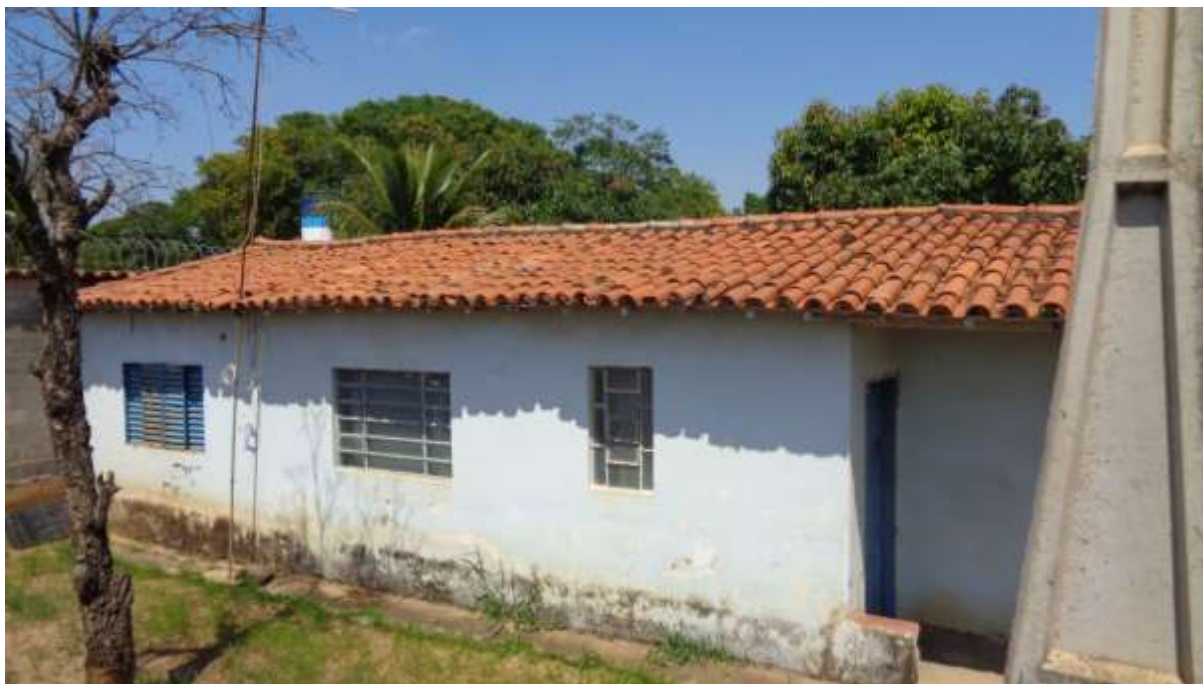
FOTO N.º 07- Tomada da construção do imóvel avaliando.
