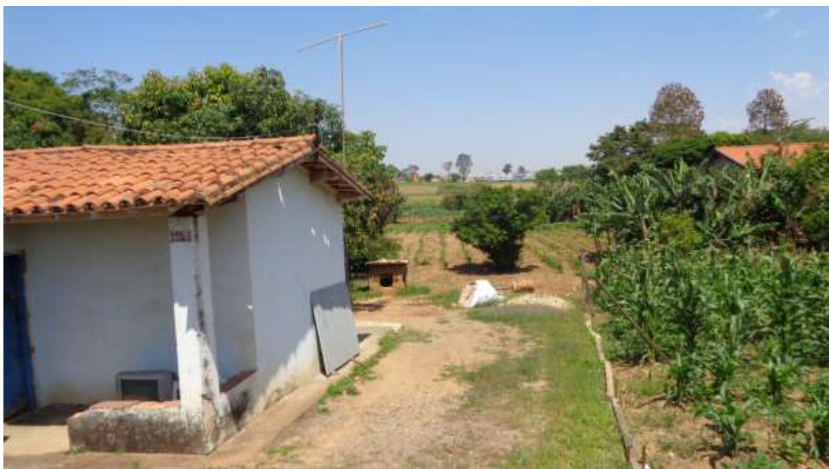
FOTO N.º 06- Vista interna do imóvel avaliando.
