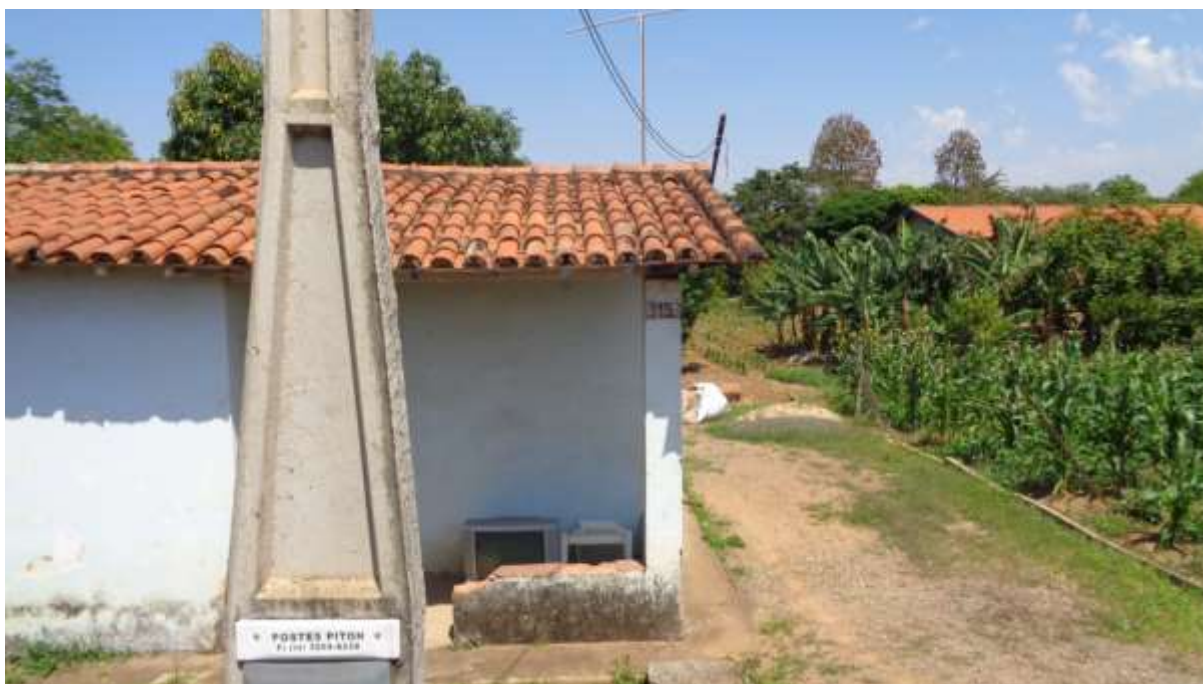
FOTO N.º 08- Aspecto da construção do imóvel avaliando.
