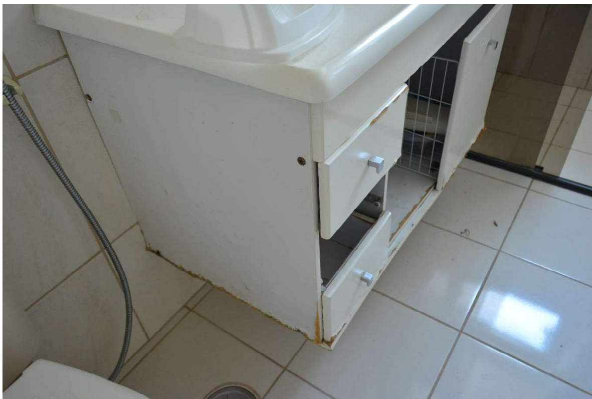
FOTO 50: MÓVEL DO BANHEIRO APRESENTA DANOS E PEÇAS FALTANDO.
