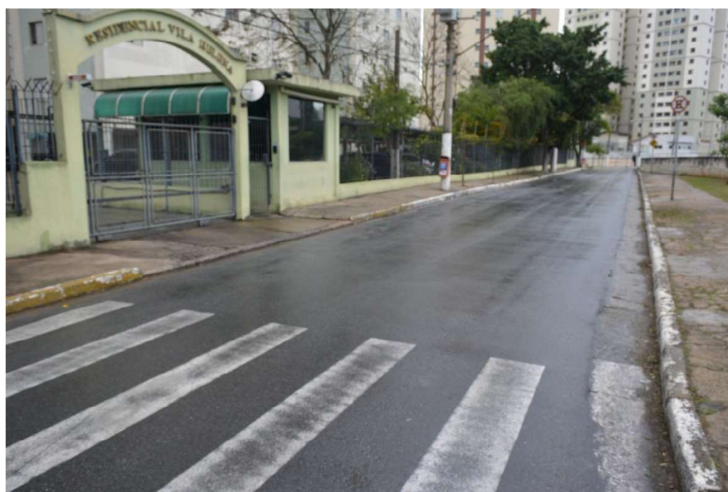
FOTO 02: VISTA NO OUTRO SENTIDO DA VIA.
