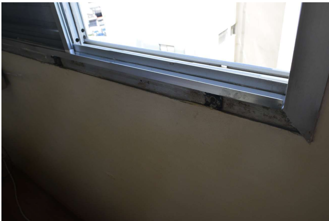
FOTO 58: FALTA A GUARNIÇÃO DA JANELA DO DORMITÓRIO 1.
