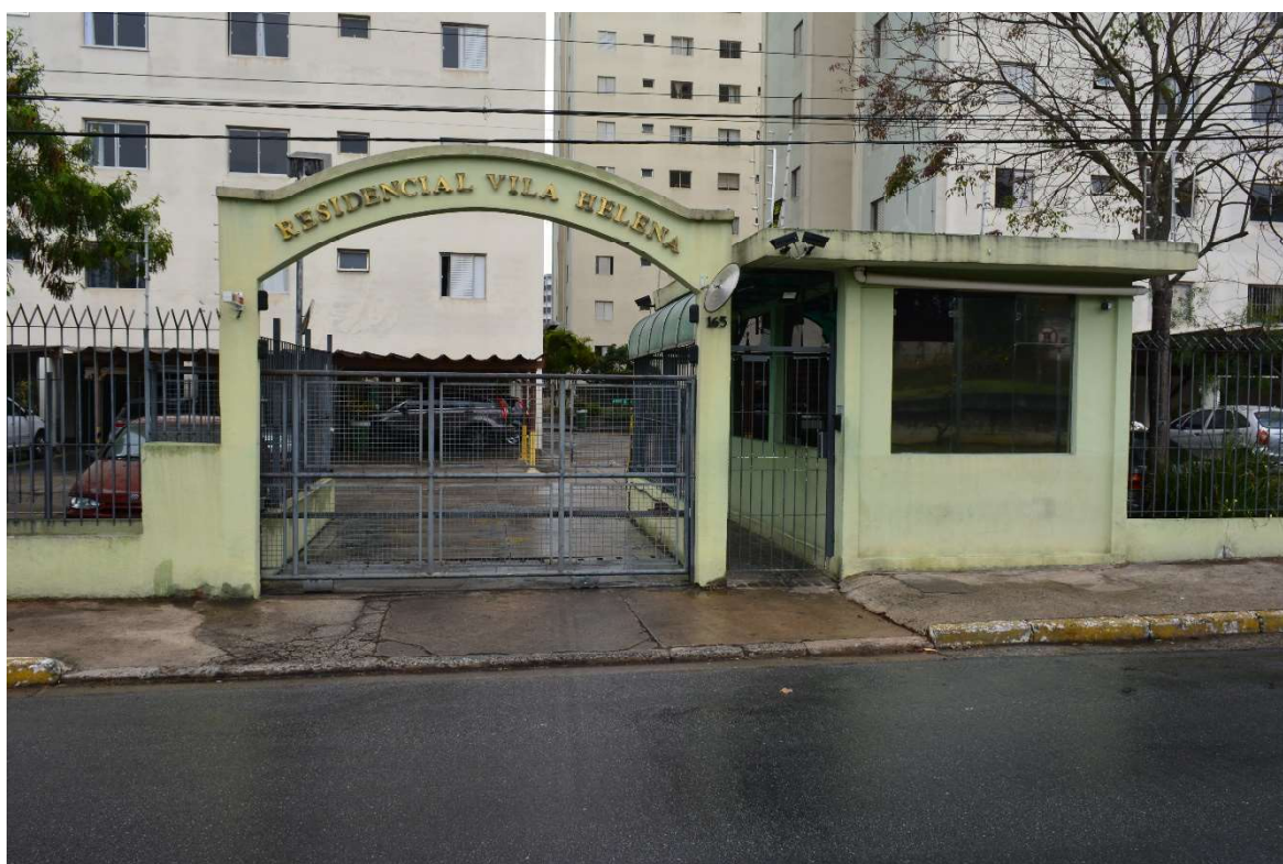
FIGURA 1: VISTA DA ENTRADA DO IMÓVEL AVALIANDO.
