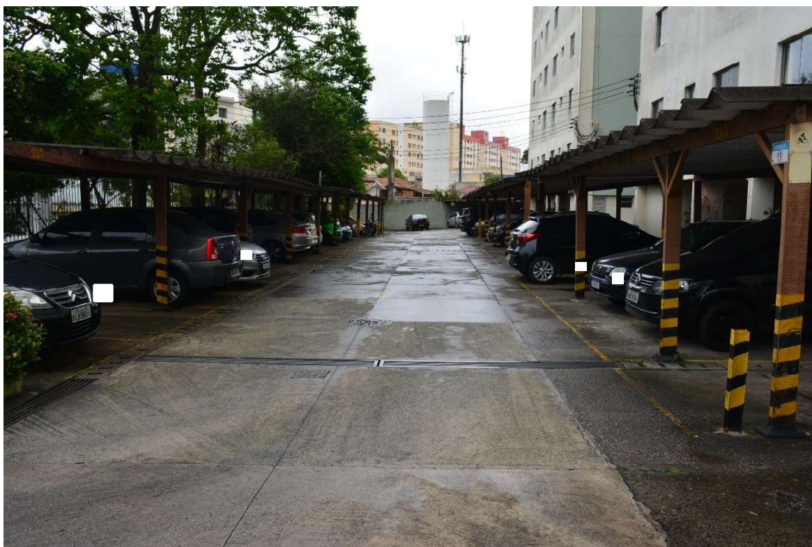
FOTO 11: VISTA DA CIRCULAÇÃO INTERNA DE VEÍCULOS.
