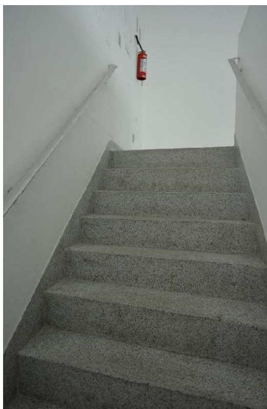
FOTO 25: ESCADA DE ACESSO AO SALÃO DE FESTAS, CONTINUAÇÃO.
