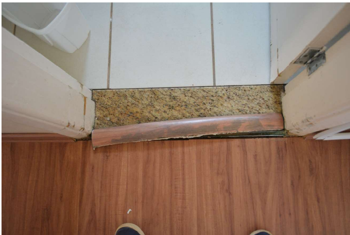
FOTO 49: PROBLEMAS COM O PISO E OS BATENTES DA PORTA DO BANHEIRO.
