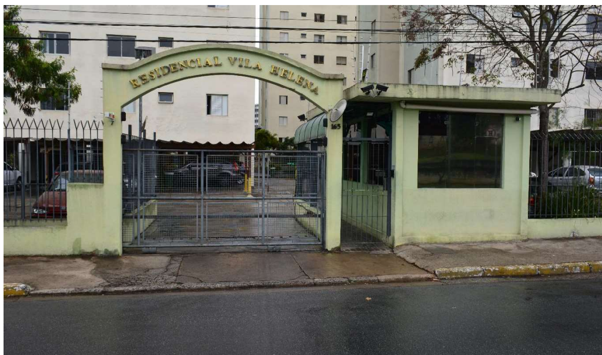
FOTO 04: VISTA DA PORTA DE ENTRADA DO IMÓVEL OBJETO DA PRESENTE AÇÃO NA RUA NOEL ROSA.
