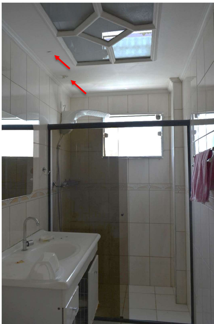
FOTO 48: VISTA DO BANHEIRO, DESCASCADOS DE PINTURA NO TETO.
