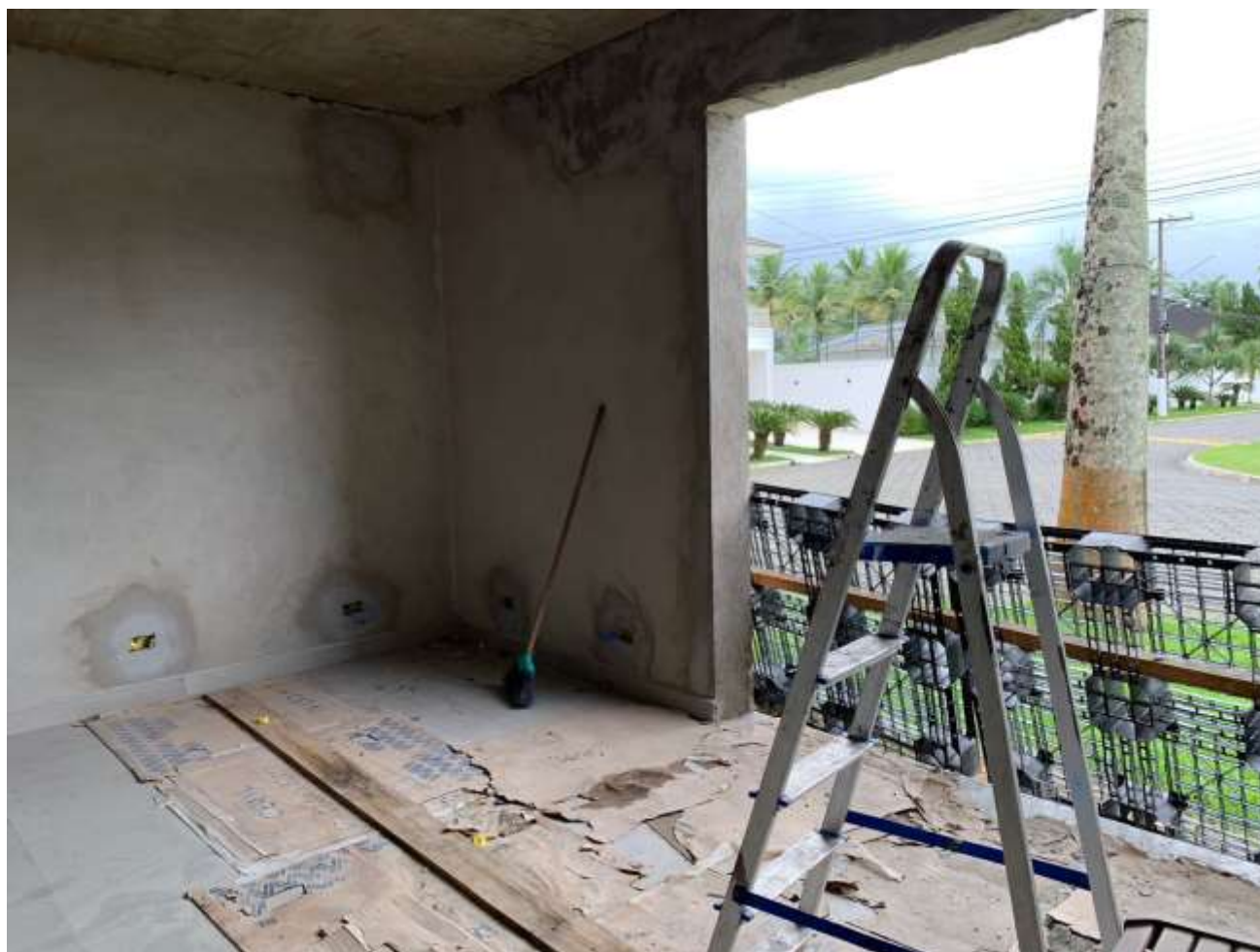
FOTO 12 - Detalhe do ambiente com reforma em andamento.
