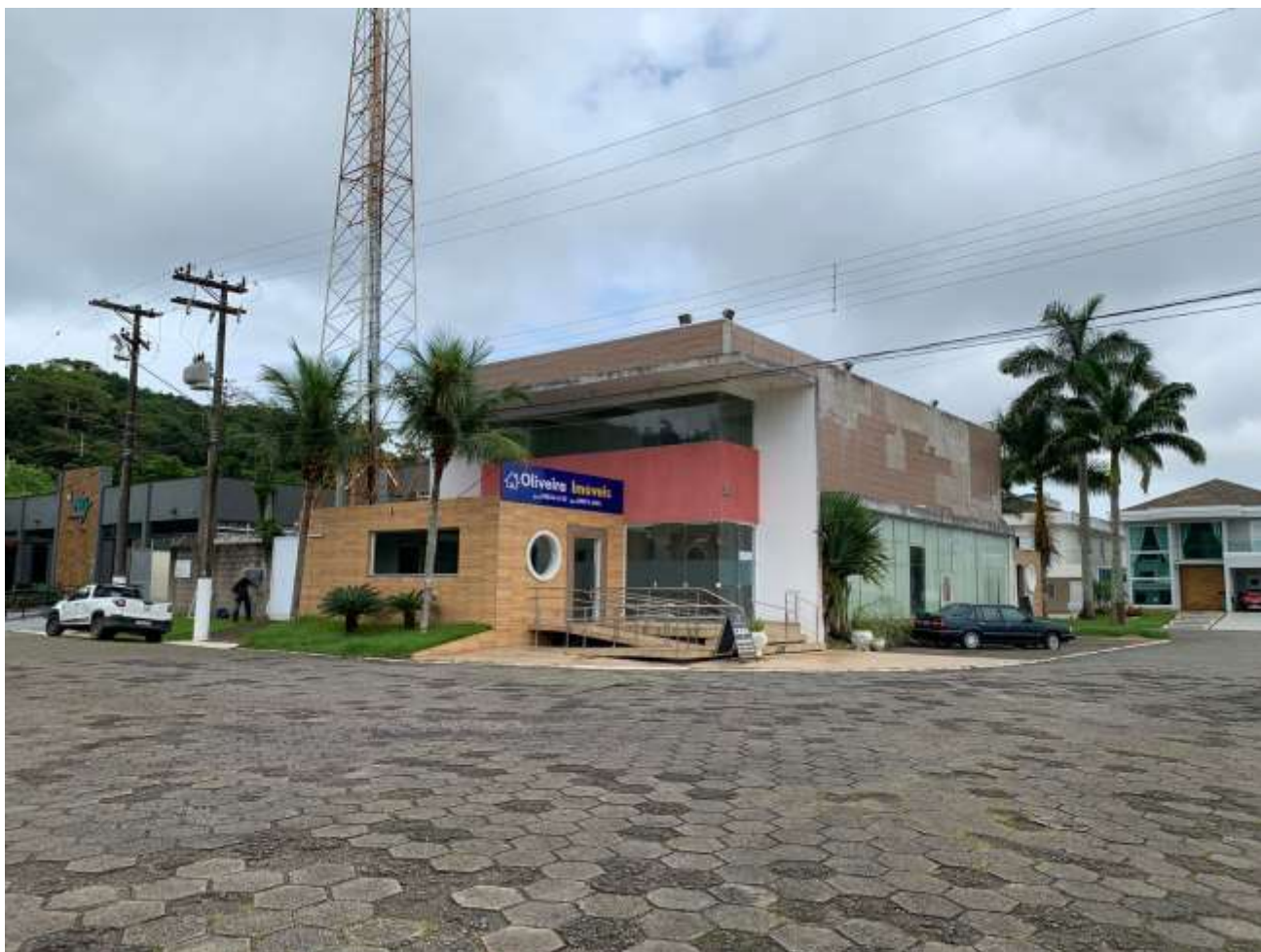
Figura 1 – Vista Geral do imóvel – fachadas 01 e 02 (terreno com 3 frentes).
