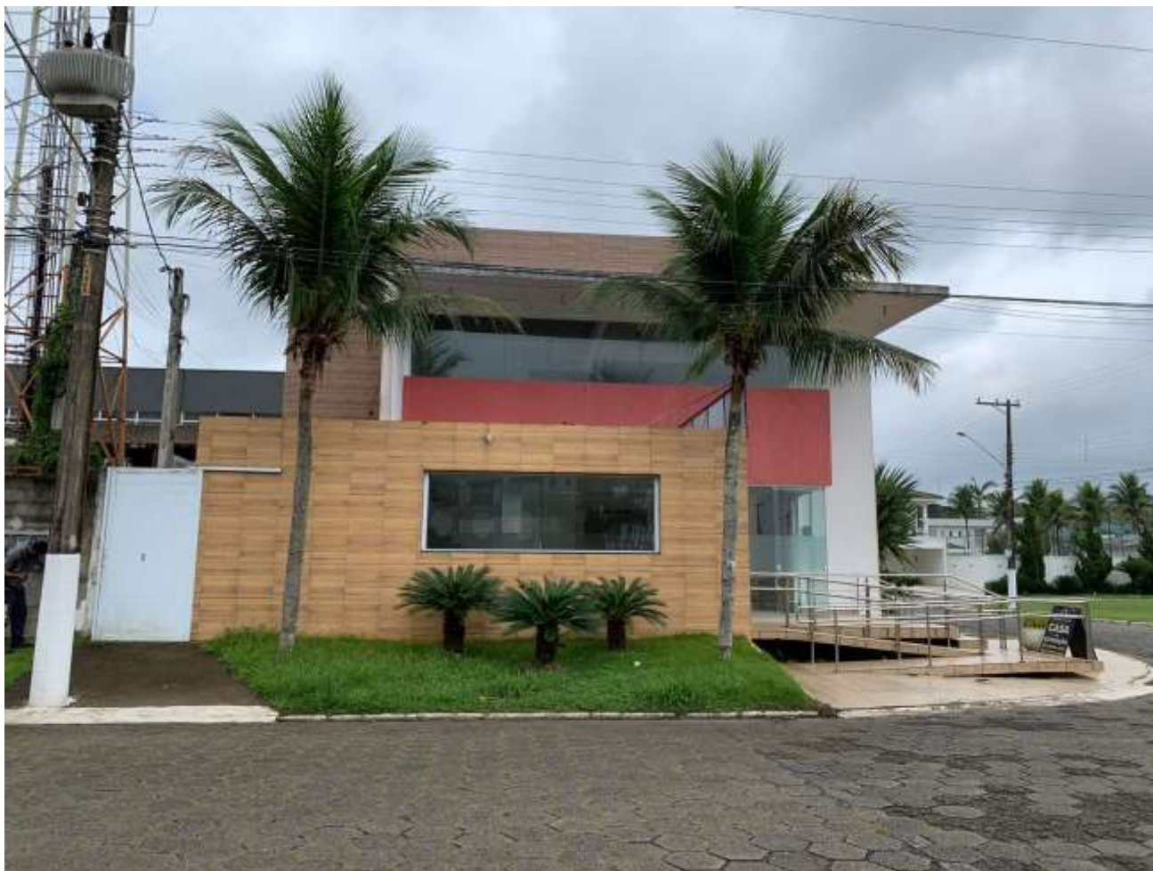
FOTO 1 - Detalhe da Fachada Principal 01 do imóvel em avaliação.
