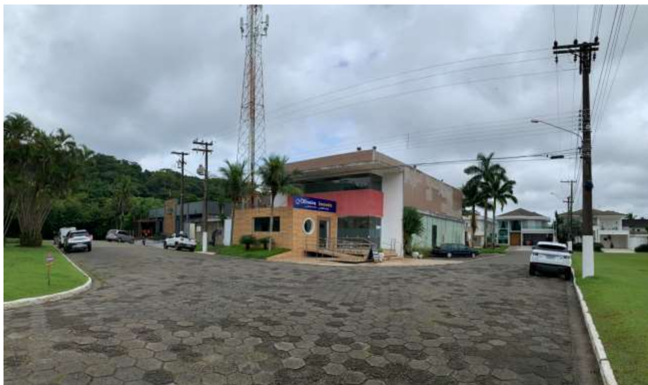
FOTO 5 – Detalhe da implantação do imóvel na confluência de 3 ruas.
