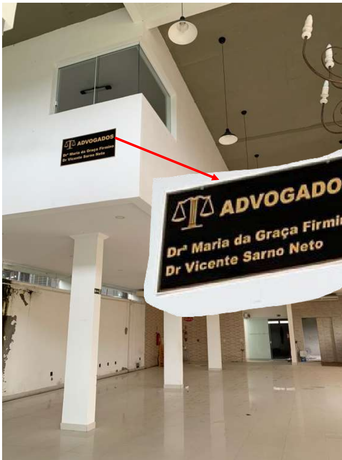
FOTO 18 Vista Geral do Salão Principal e Detalhe da placa de identificação de escritório dos advogados: Dra. Maria da Graça Firmino e Dr. Vicente Sarno Neto. Constatação de local em reforma.
