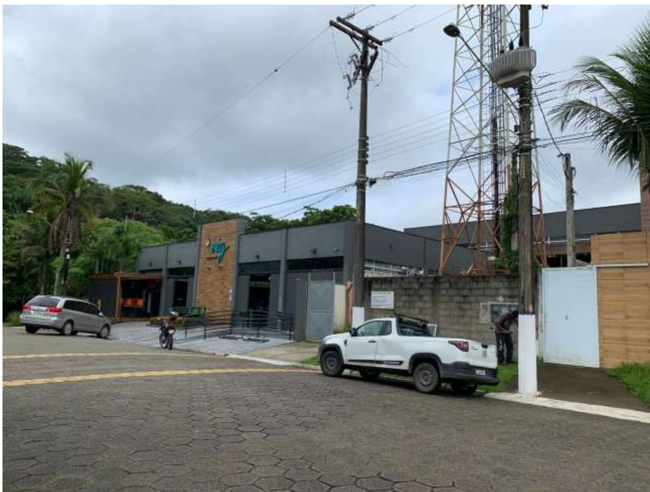
FOTO 9 - Detalhe do viário e imóveis vizinhos considerando a fachada principal 1.
