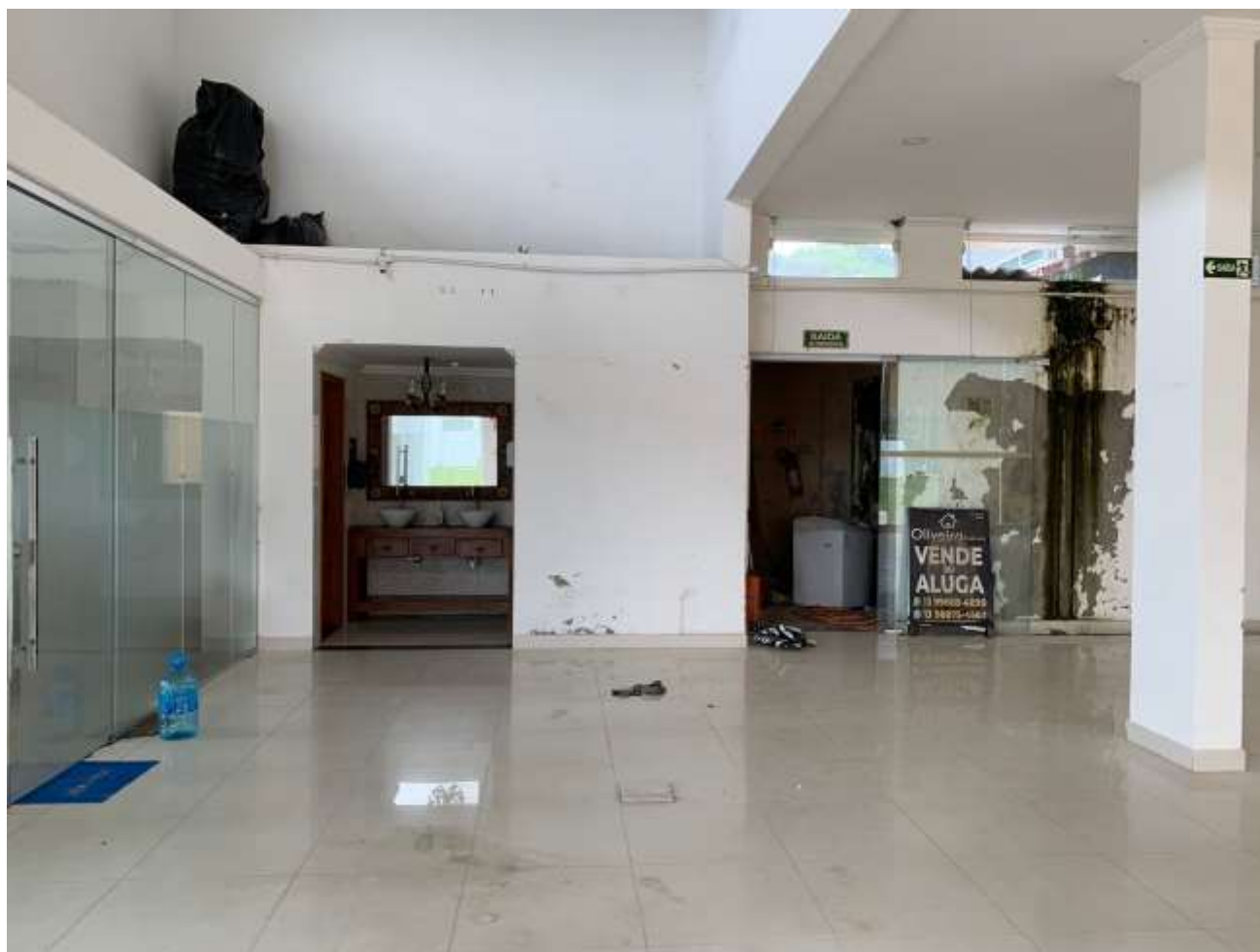
FOTO 16 - Vista Geral do acesso aos banheiros e copa.
