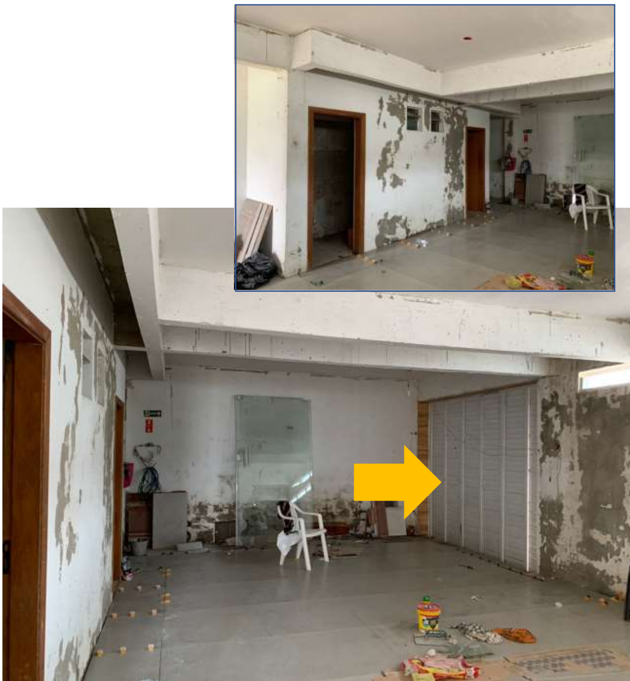
FOTO 19 – Detalhe do ambiente com reforma em andamento. A marcação em amarelo sinaliza a entrada pela fachada principal 03.
