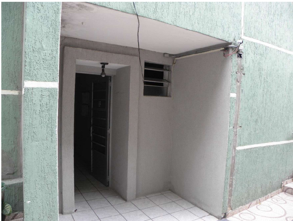
Foto: Visão da entrada térrea, com acesso às escadas.
