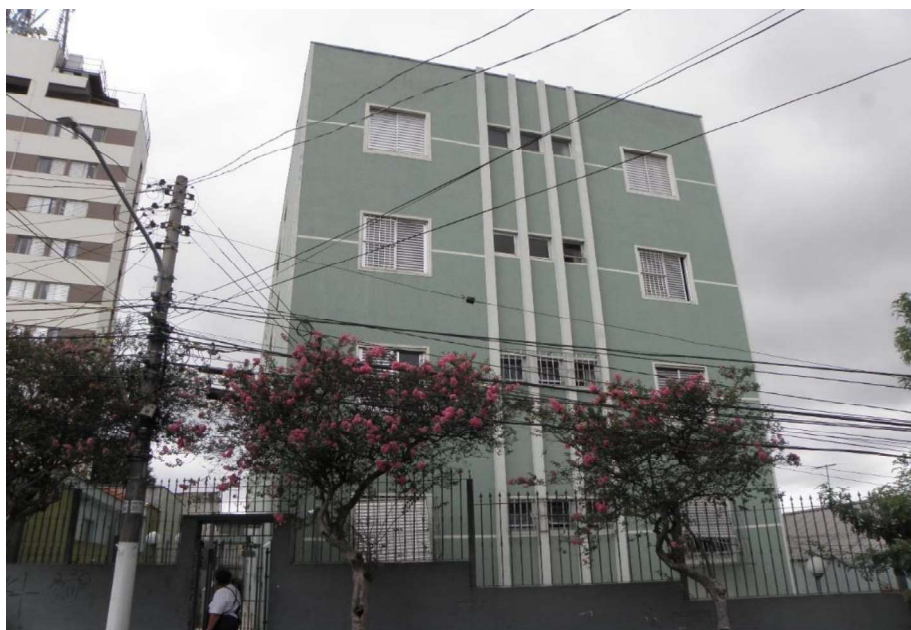
Foto: Fachada do prédio.
