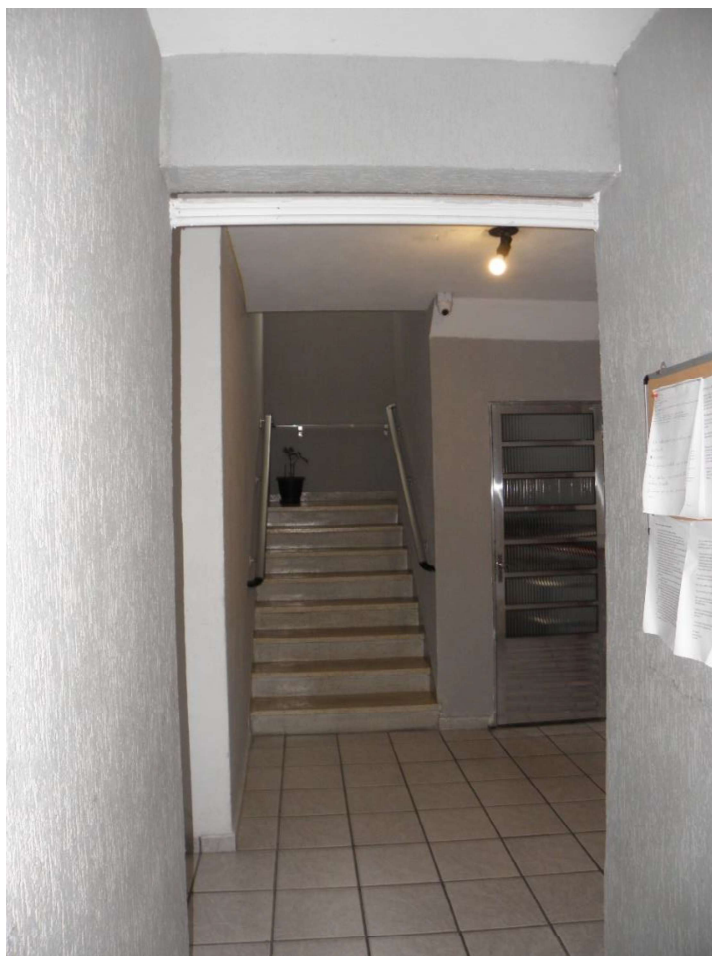
Foto: Visão do corredor térreo de acesso às escadas.
