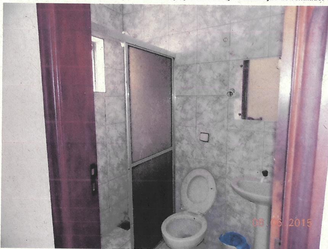
Fotografia 24: Visão de banheiro de apartamento padrão do Bloco "B" podendo ser observado acabamento de cerâmica no piso e paredes, peças de baixo padrão (pia, vaso sanitário, etc.).
