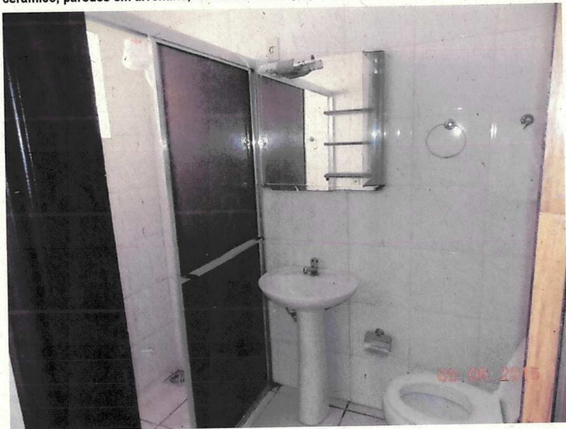
Fotografia 26: Visão de banheiro de apartamento padrão do Bloco "C" podendo ser observado acabamento de cerâmica no piso e paredes, peças de baixo padrão (pia, vaso sanitário, etc.).
