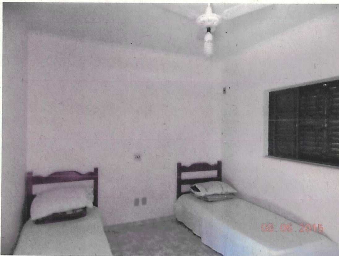
Fotografia 23: Visão de apartamento padrão do Bloco "B" podendo ser observado acabamento de piso cerâmico, paredes em alvenaria, cobertura com laje, janelas em aço e instalação de ventilador de teto.
