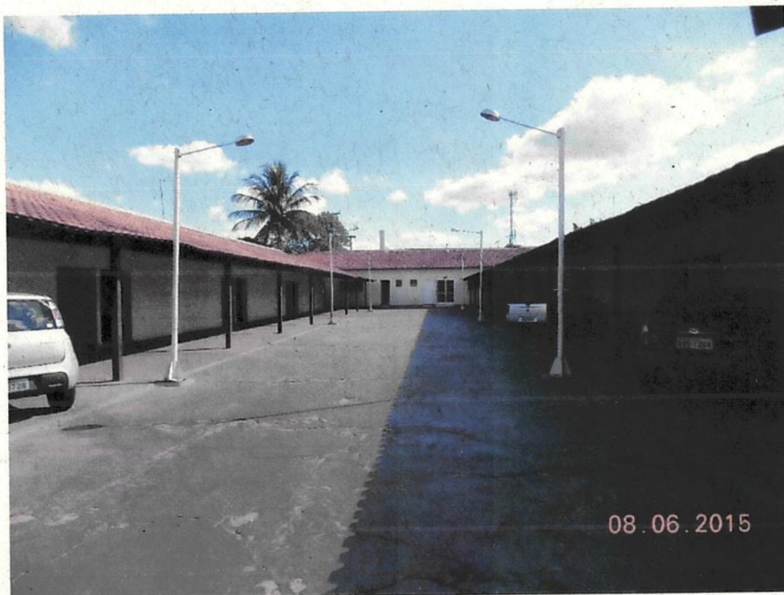
Fotografia 2: Visão geral do Bloco "A", podendo ser observado piso cimentado, entrada de apartamentos, garagens cobertas e ao fundo porta do almoxarifado e refeitório.
