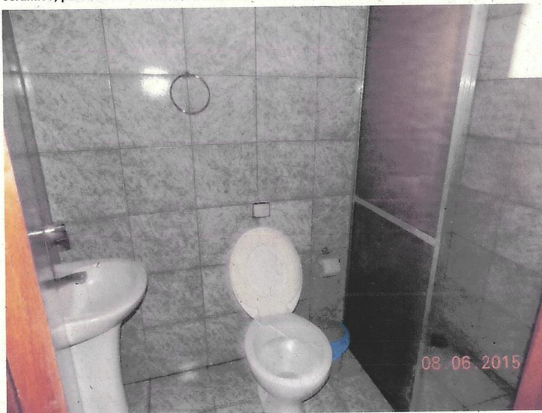
Fotografia 22: Visão de toailete de apartamento padrão do Bloco "A" podendo ser observado acabamento de cerâmico no piso e paredes, peças de baixo padrão (pia, vaso sanitário, etc.).
