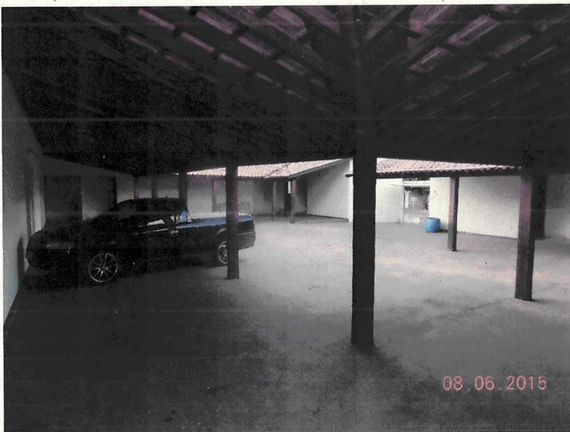
Fotografia 20: Visão geral do Bloco "C" podendo ser observado as entradas de acessos aos apartamentos, patio cimentado e cobertura de garagens para veículos.
