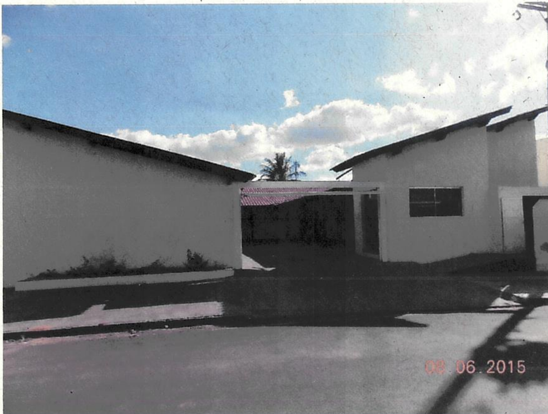
Fotografia 17: Visão externa do Bloco "B" podendo ser observado a direita a área de recepção inativa.
