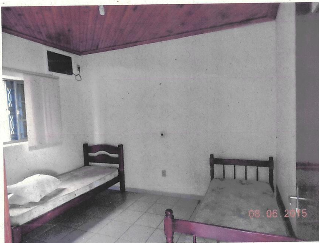
Fotografia 21: Visão de apartamento padrão do Bloco "A" podendo ser observado acabamento de piso cerâmico, paredes em alvenaria, cobertura com forro, janelas em aço e instalação de ar condicionado.
