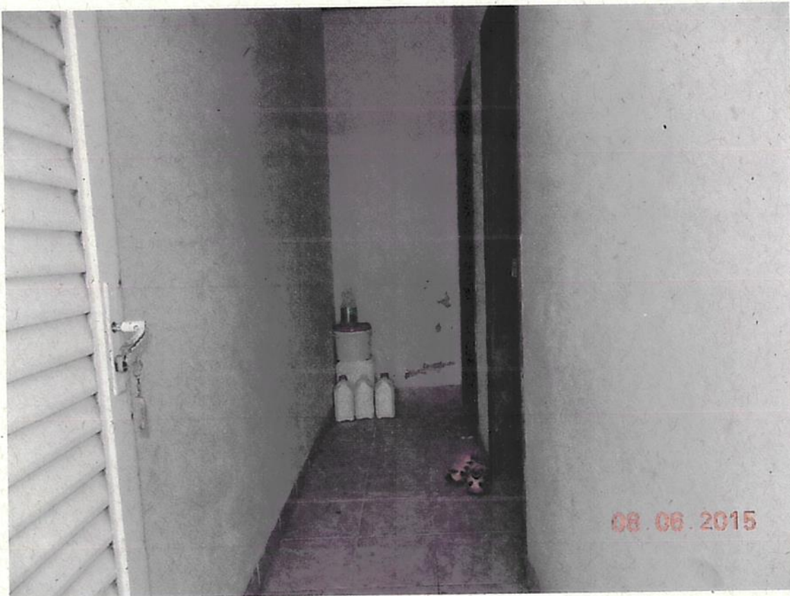
Fotografia 10: Acesso ao almoxerifado.
