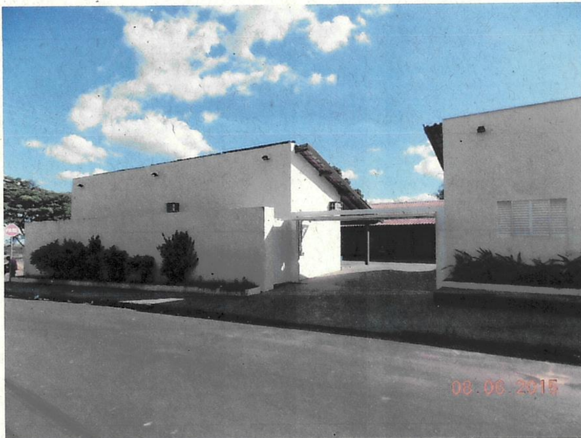
Fotografia 19: Visão externa do Bloco "C".
