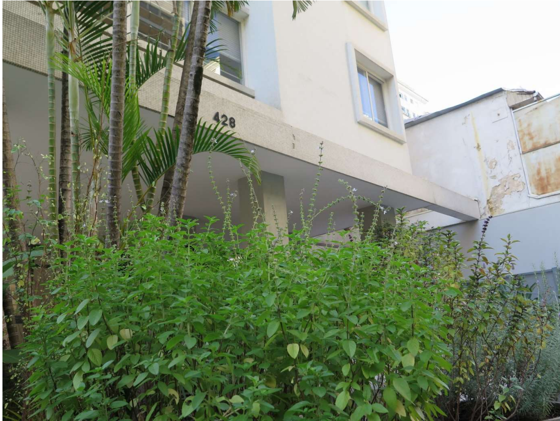
Vista do Hall de Entrada
