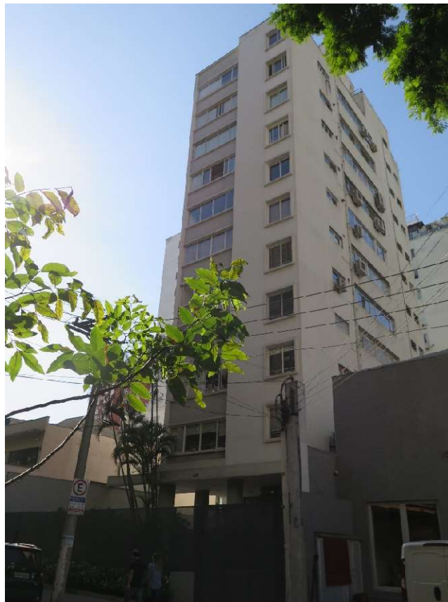
Vista do edifício
