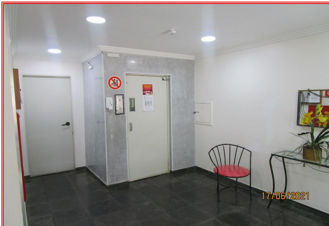
Foto nº 10: Vista parcial do hall de elevador.
