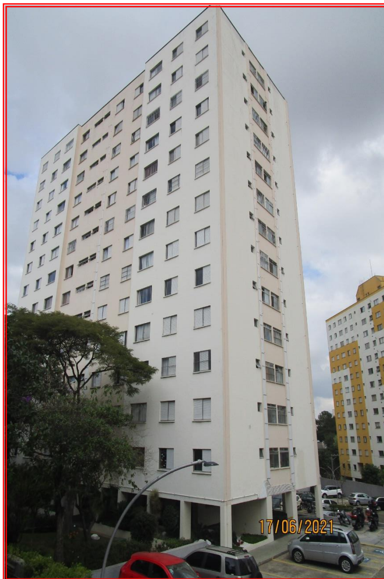
Foto nº 06: Vista geral das fachadas do Bloco 1 “Anhangá”, onde se localiza o imóvel avaliando, composto pelo apartamento nº 53 do 5º andar.
