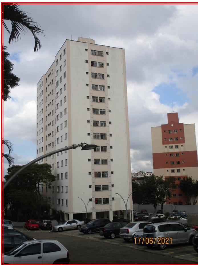
Foto: Vista geral do Bloco 1 “Anhangá”, onde se localiza o imóvel avaliando (apartamento 53).
