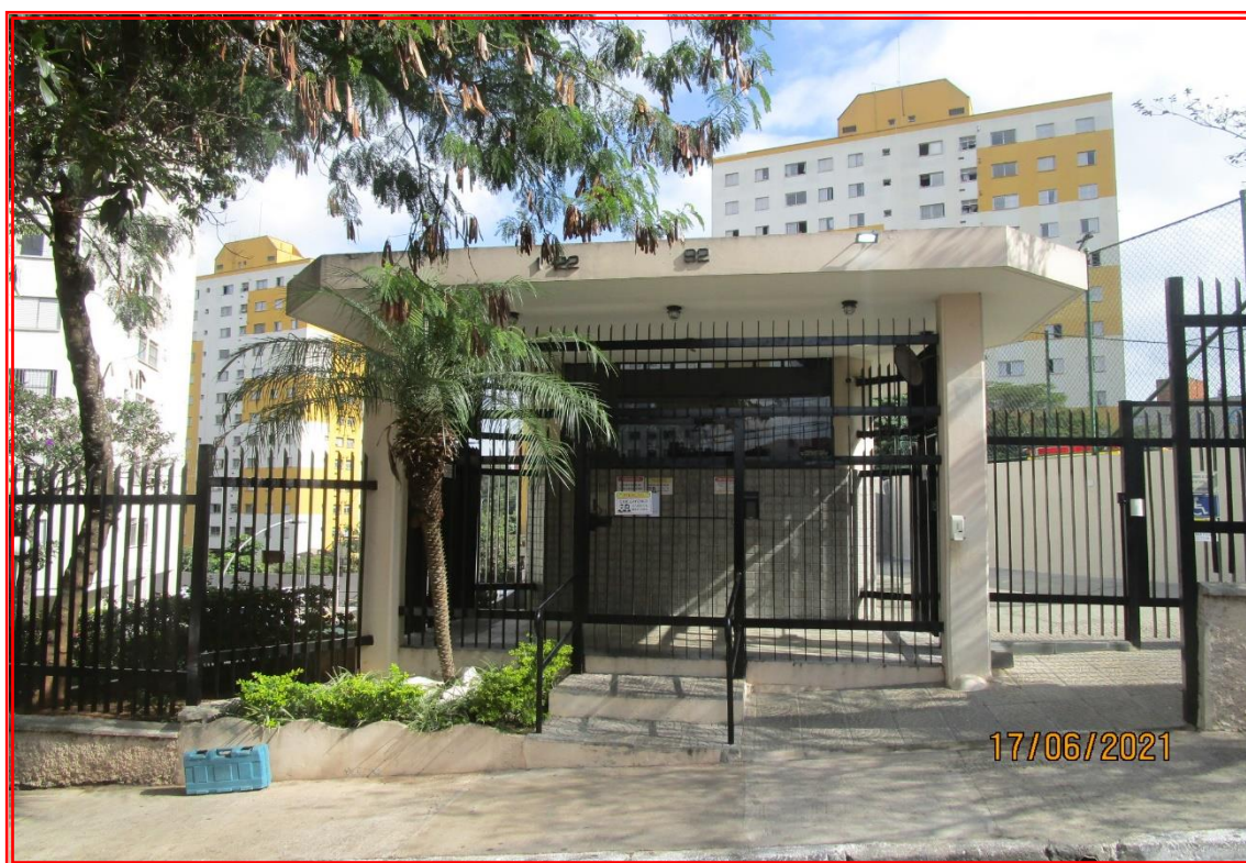
Foto nº 01: Vista geral da portaria central de moradores/visitantes.
