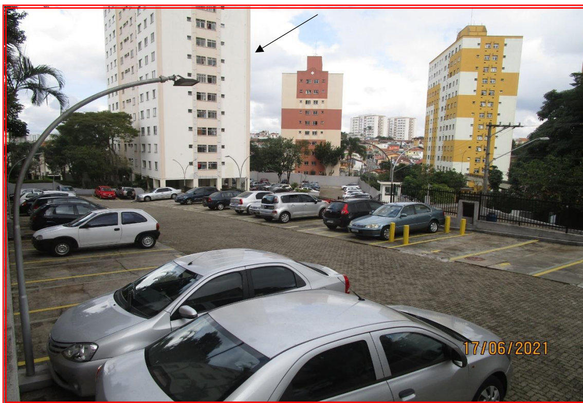
Foto nº 02: Vista geral de parte da área de estacionamento, com detalhe para o Bloco 1 “Anhangá” aos fundos.
