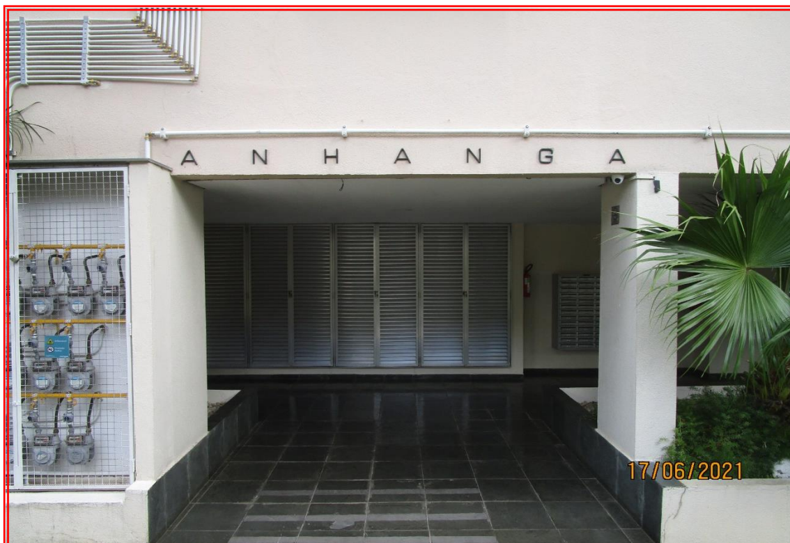
Foto nº 08: Vista geral do acesso ao Bloco 1 “Anhangá”.
