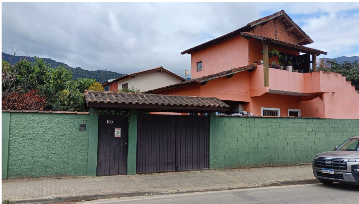
Figura 1 - Vista frontal do nº 190, com muro, portões de acesso e edificações visíveis ao fundo.
