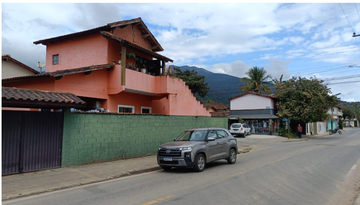
Figura 2 - Vista panorâmica do imóvel e do logradouro, evidenciando pavimentação, passeio e infraestrutura aérea.
