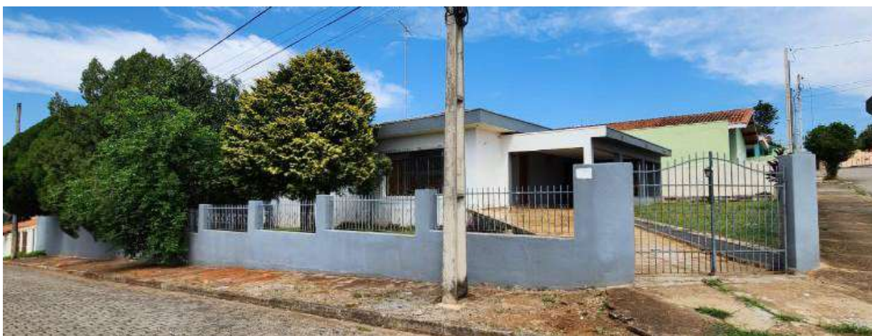
Frente do imóvel para Rua Pio XII
