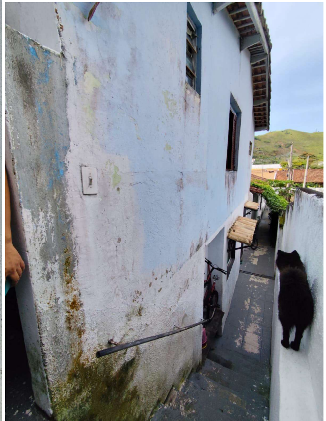
Lateral vista da casa dos fundos
