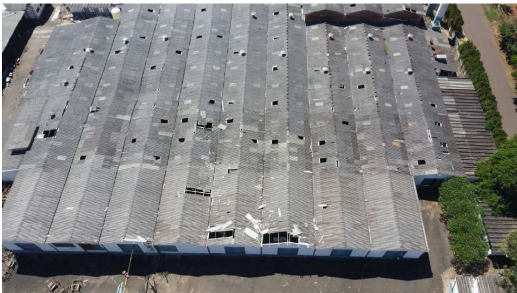
Vista do telhado dos Barracões da Unidade de Produção
