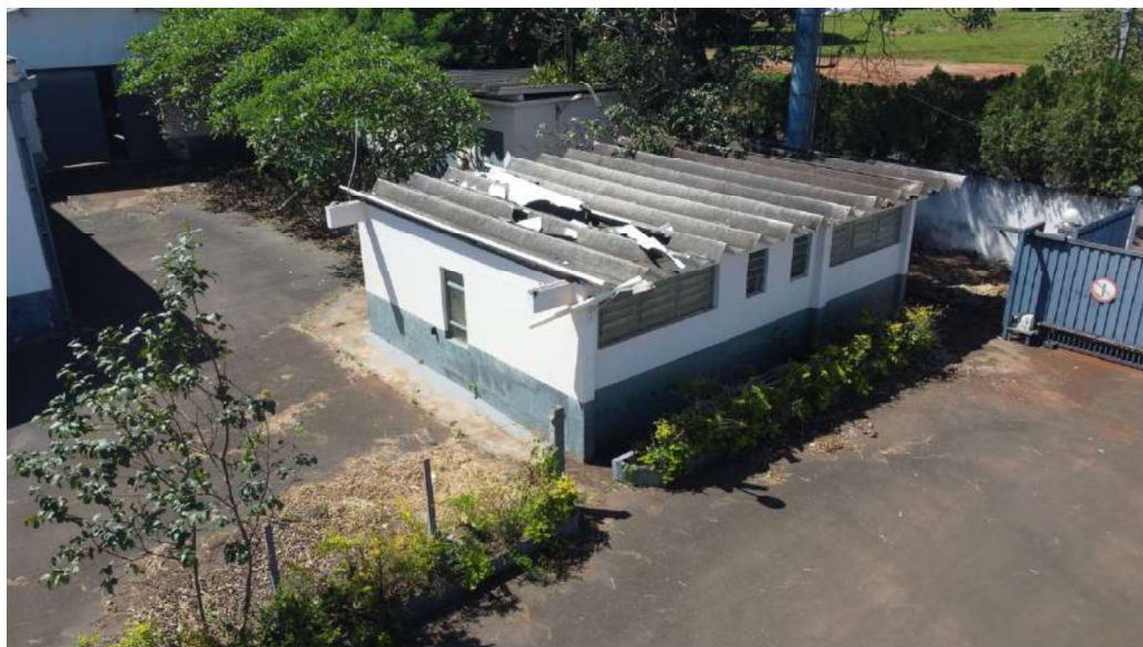
Vista do Escritório e Almoxarifado
