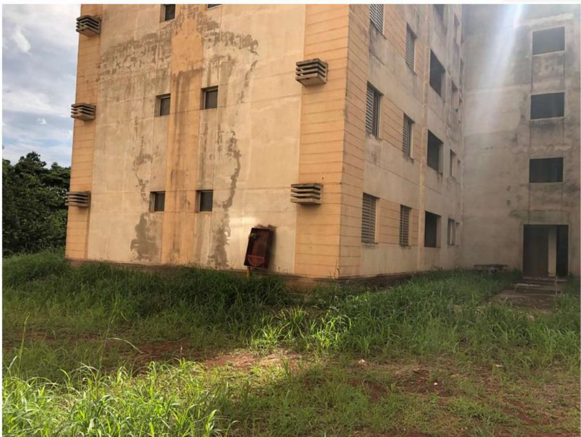
Avenida Duque de Caxias, 689 – Fórum Estadual Foro Central de Londrina Pr.
