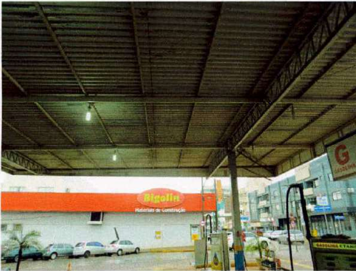
FOTO 05 - COBERTURA METALICA - POSTO
