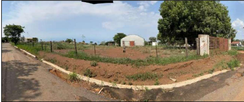
Detalhes da benfeitoria do imóvel avaliando.
