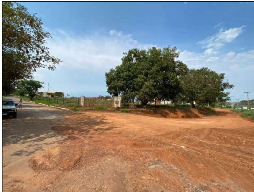
Figura 8: Detalhe da pavimentação primária existente no logradouro do Lote nº 2, Quadra nº 1 - Chácara Cachoeirão, Jaciara - MT. Fonte: Unisafe Consultoria, 2021
