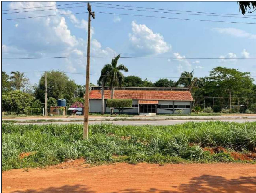
Figura 1: Avenida Pajé que dá acesso ao imóvel. Fonte: Unisafe Consultoria, 2021.
