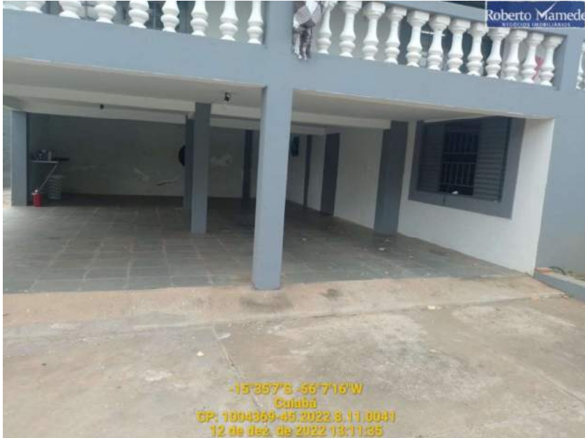
Fig 06 – Garagem coberta (subsolo)
