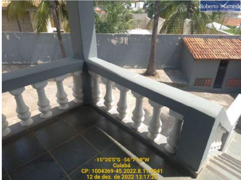
Fig 09 – Vista da sacada 1
