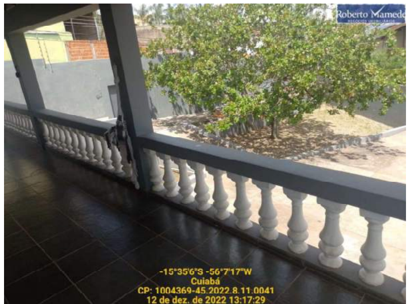
Fig 10 – Vista da sacada 2
