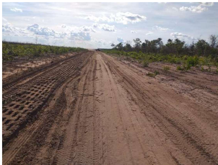
Estrada de acesso
