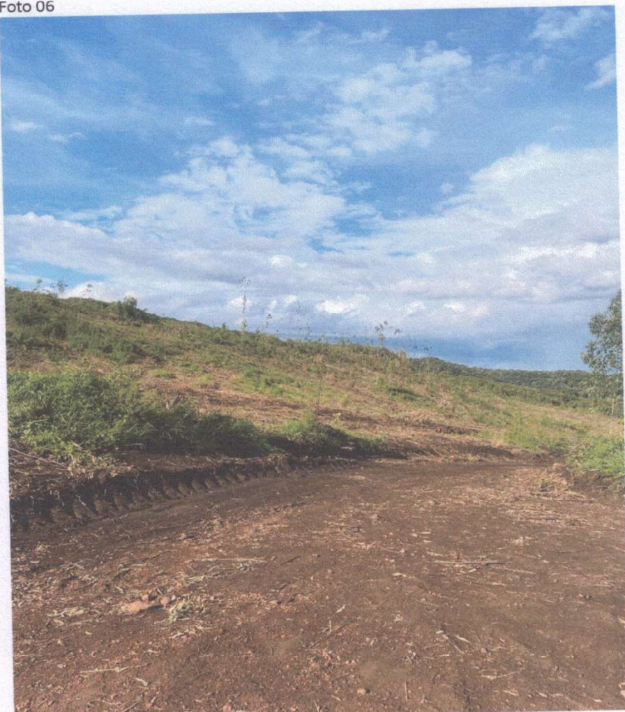
Foto demonstrativa do desnível do solo
