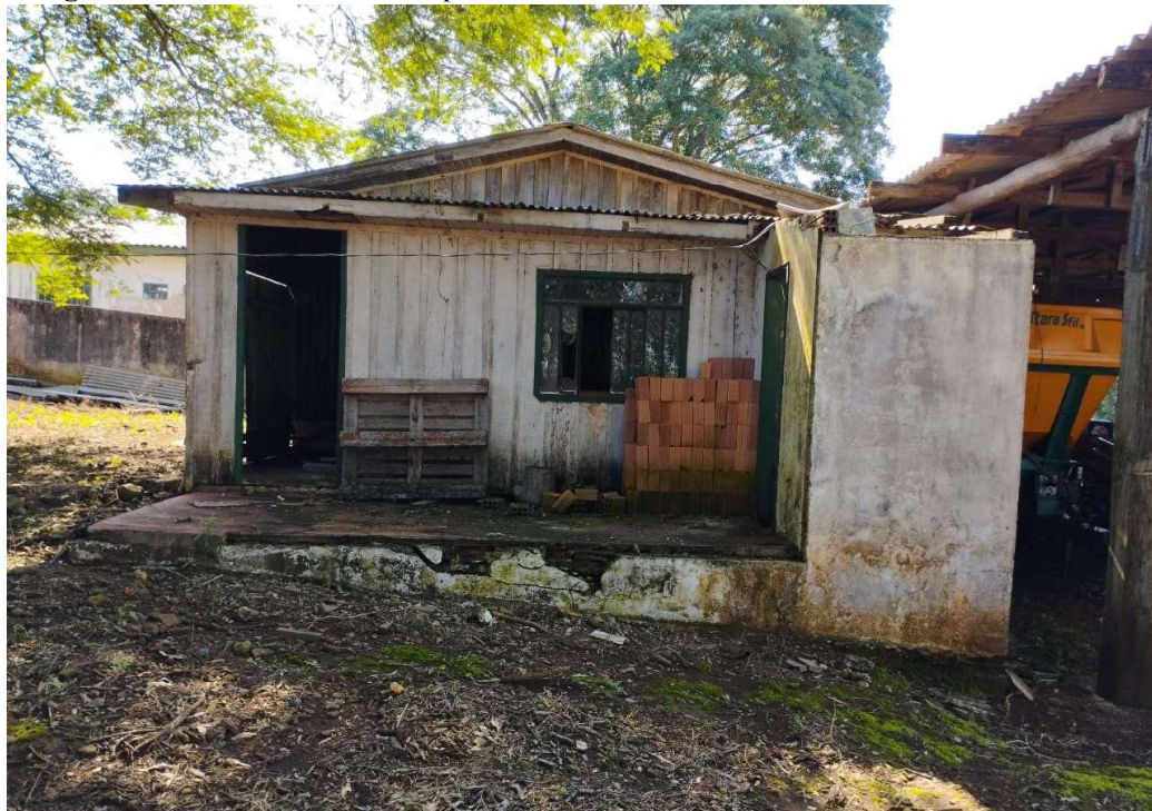
Imagem 63 – Vista Posterior Galpão 01
