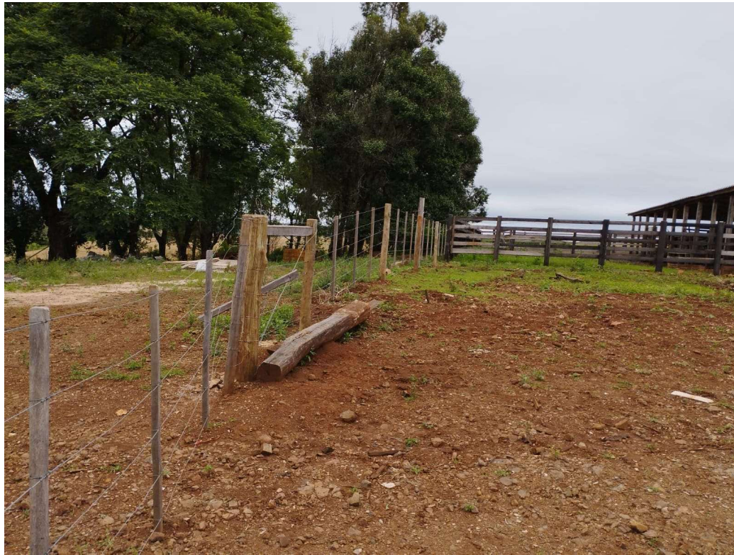
Imagem 70 - Trecho de Cercas
