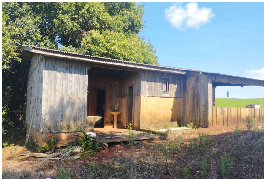
Imagem 65 – Vista Lateral Esquerda Galpão 02
