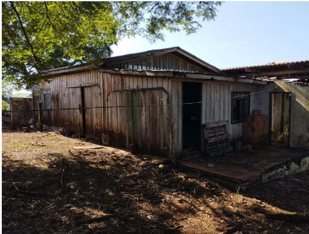
Imagem 62 – Vista Lateral e Posterior Galpão 01
