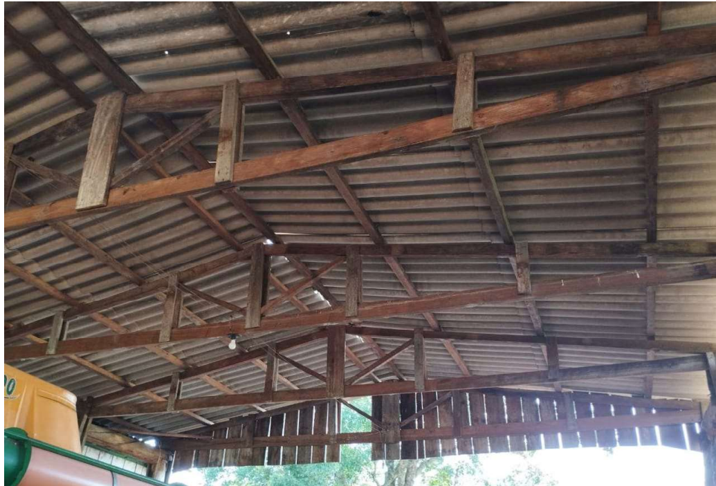
Imagem 60 – Vista Interna Garagem de Implementos 02
