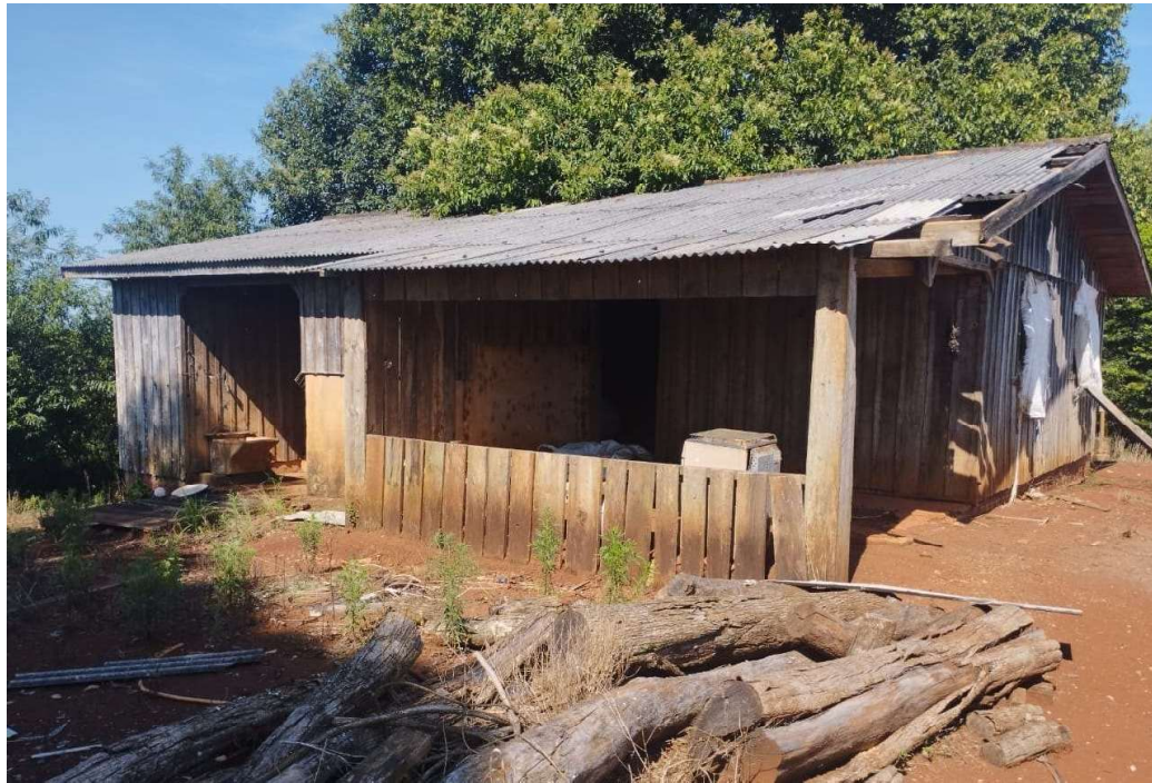
Imagem 64 – Vista Frontal e Lateral Esquerda Galpão 02
