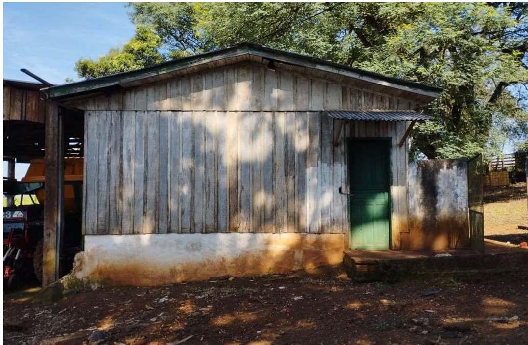
Imagem 61 – Vista Frontal Galpão 01
