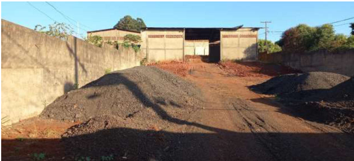
Figura 7 – Interior do imóvel. Frente do galpão.
