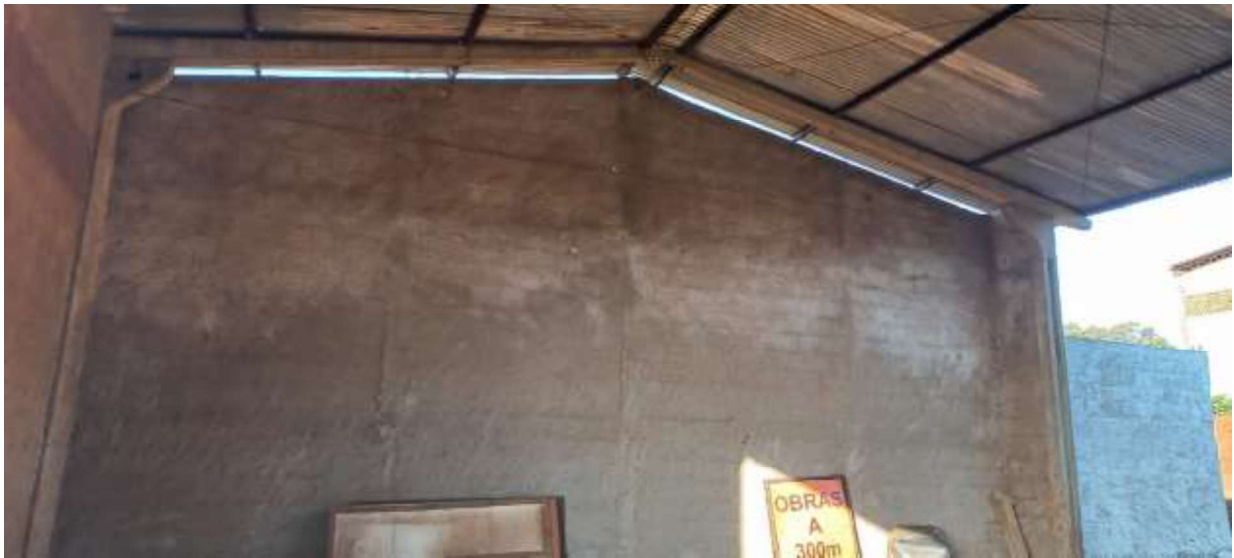
Figura 10 Interior do galpão.
