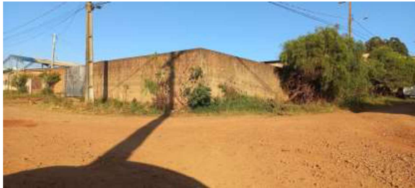
Figura 5 –Muro do imóvel entre as Ruas Flor da Serra a esquerda e Otávio Lucas Domingues à direita
