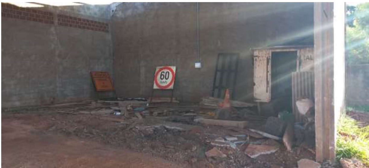
Figura 8 – Interior do galpão.
