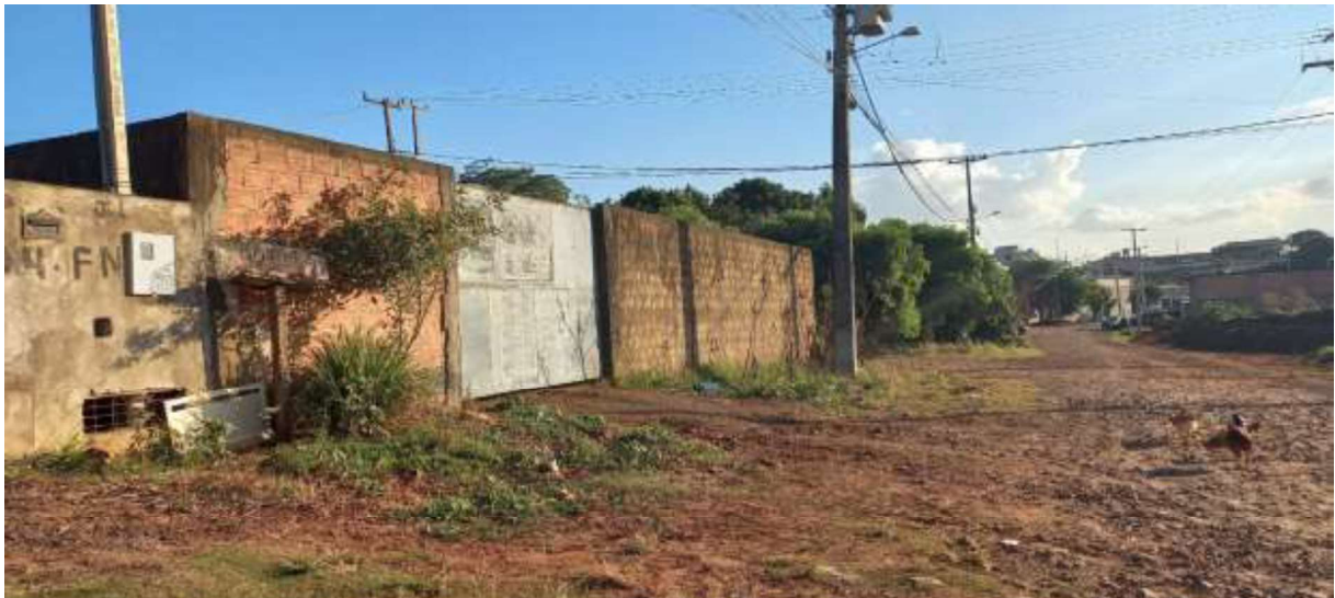
Figura 6– Frente do Imóvel na Rua Flor da Serra.
