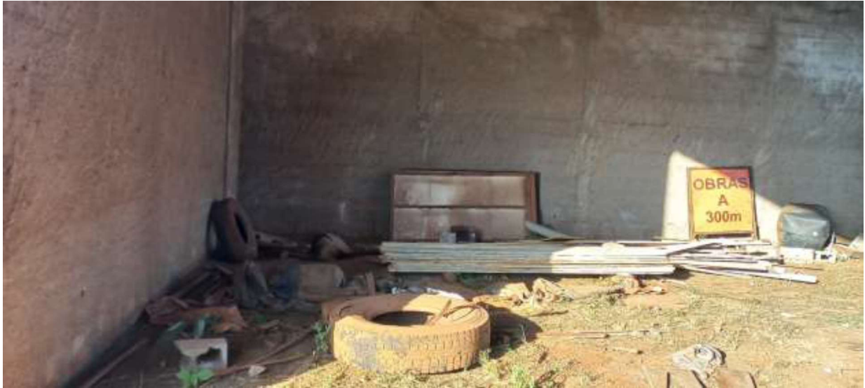
Figura 9 - Interior do galpão.
