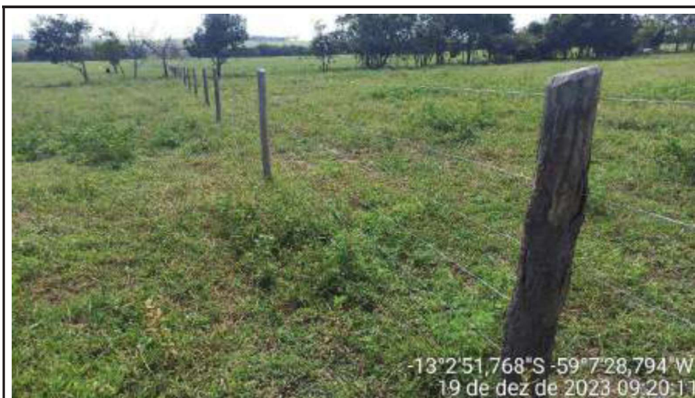
Foto nº 08 – Tirada em 19/12/2023 – Mostra cerca de itaúba com arame liso nas divisas internas do imóvel.
