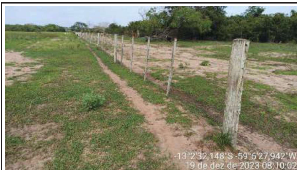
Foto nº 07 – Tirada em 19/12/2023 – Mostra cerca de itaúba com arame liso nas divisas do imóvel.
