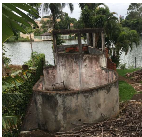
Foto 09 – Lavanderia e garagem para barcos;
