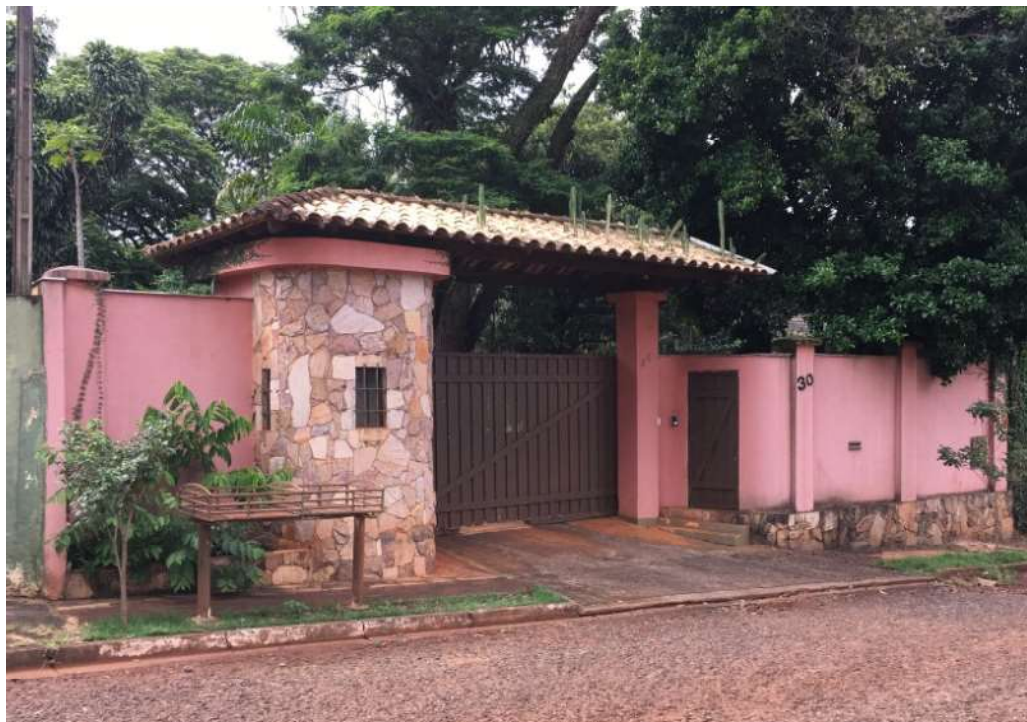
Foto 03 – Fachada Rua Flávio Luz nº 30;
