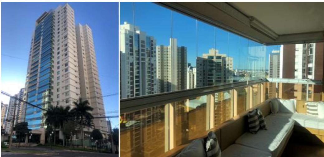
Fotos 15 – Fachada do Condomínio Le Blanc e ambiente de varanda;
