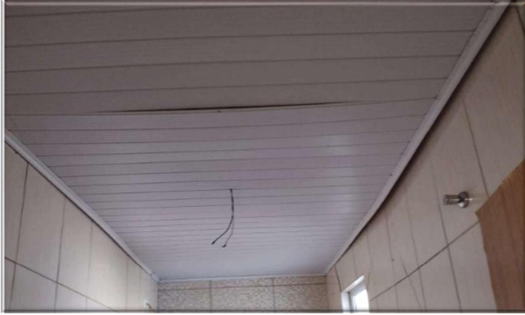
Instalação elétrica: Embutida, o imóvel encontra-se sem energia elétrica e algumas saídas de energia está com fios aparentes.
