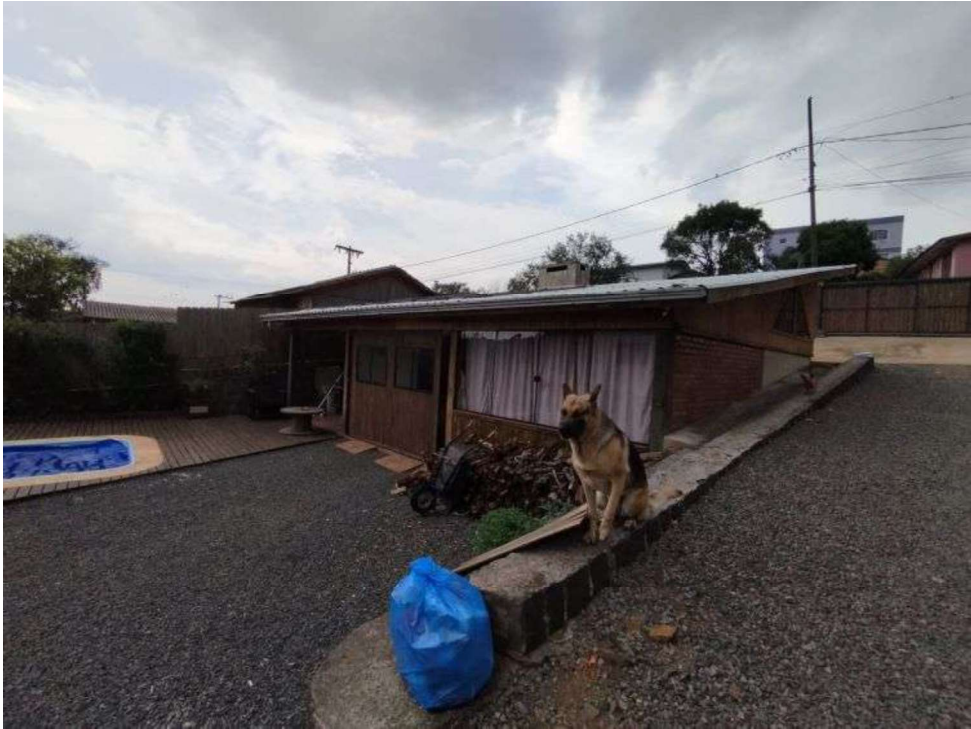
Edificação Externa (Área de Lazer);
