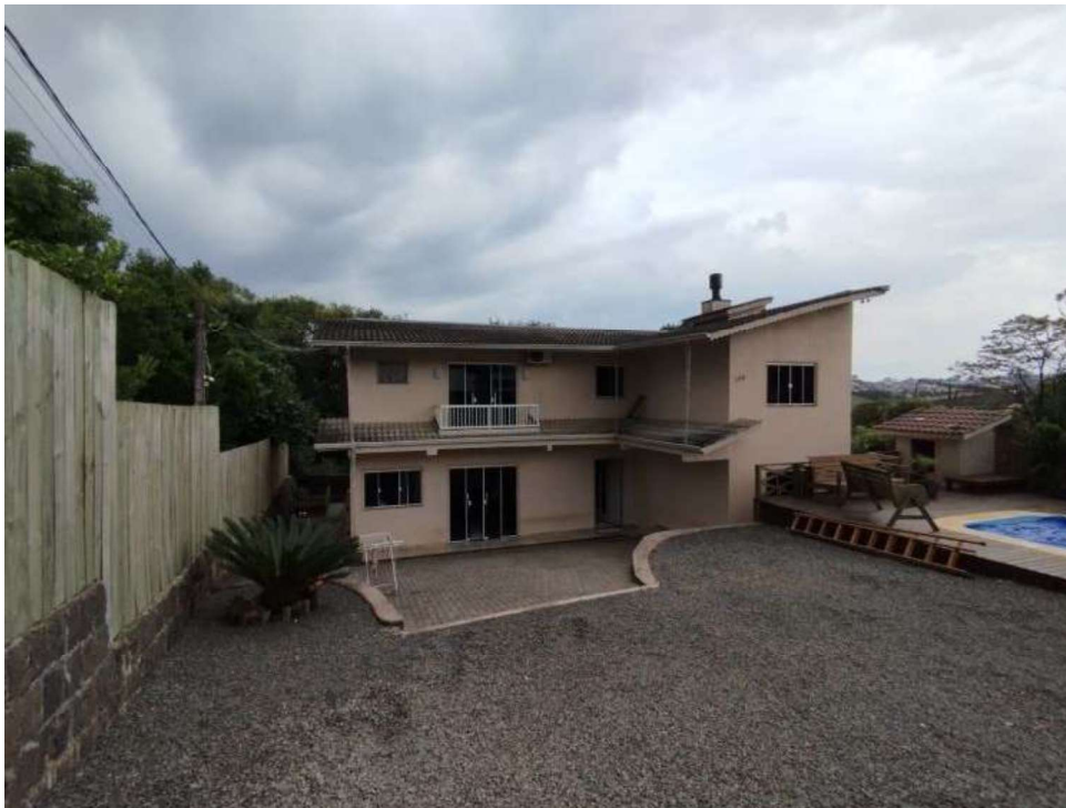
Edificação Residencial (sobrado fundos);
