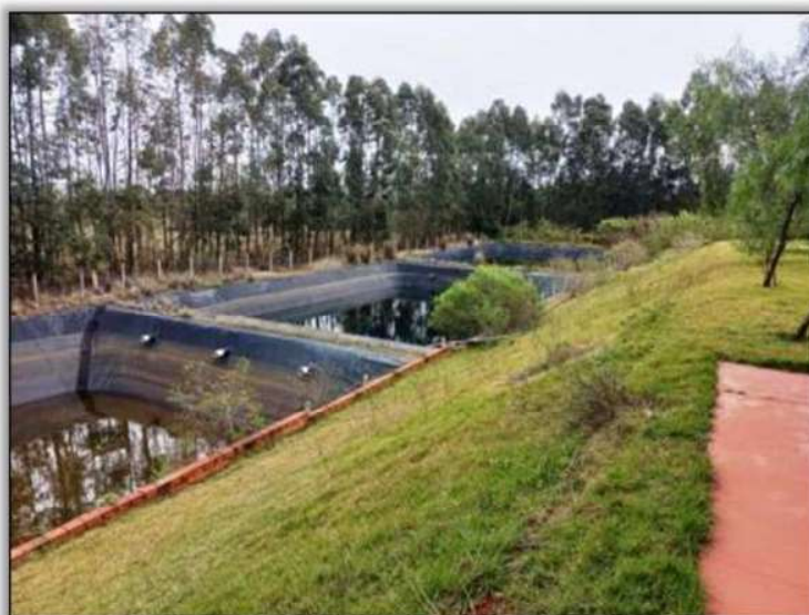
Lagoas de estabilização para tratamento de efluentes
