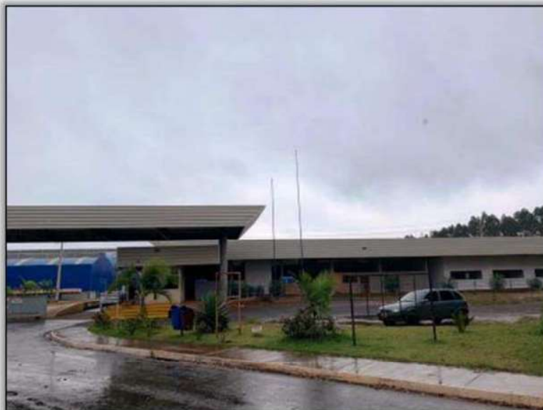
Portaria e vista parcial da área administrativa (à direita)
